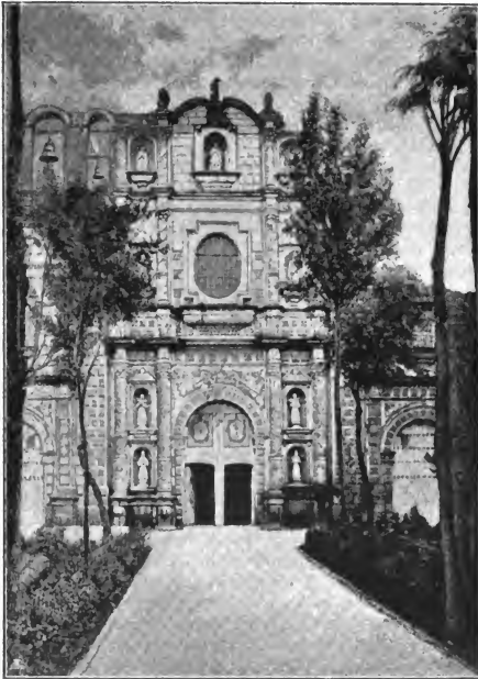
Kirche San Francisco in Cajamarca. (Zu S. 212.) (Nach einer Photographie.)
