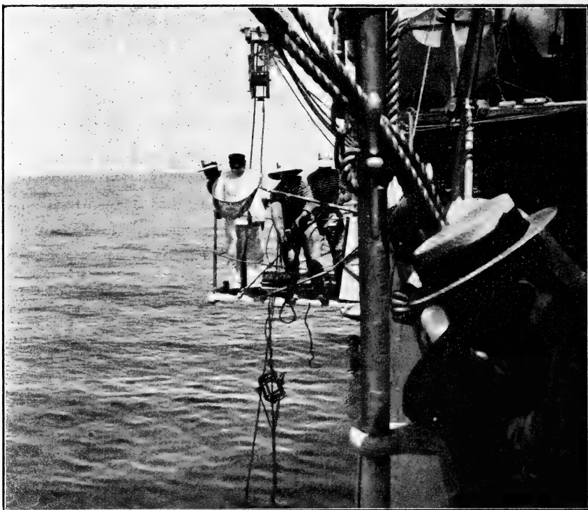
FIG. 25. — Rentrée d'un palanque de fond.
