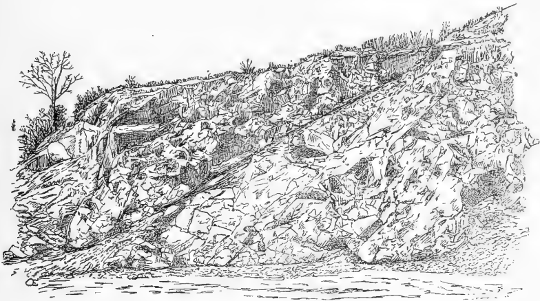
Fig. 36. — CARRIÈRE DE ST-ROCH (CHANGÉ).
