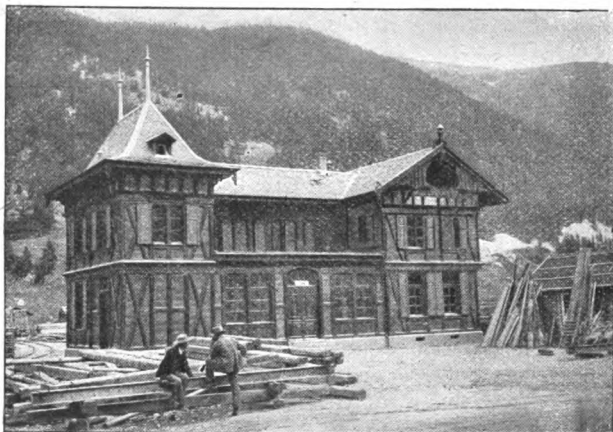
Das Stationsgebäude der Gornergratbahn in Zermatt.
