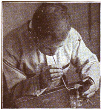
Vöten mit dem Vötrohr. (Aus „Werkbuch fürs Haus“.)
