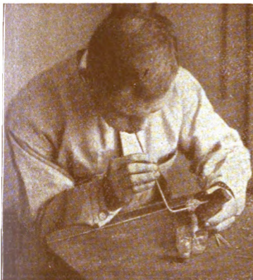
Löten mit dem Lötrohr. (Aus „Werkbuch fürs Haus“.)
