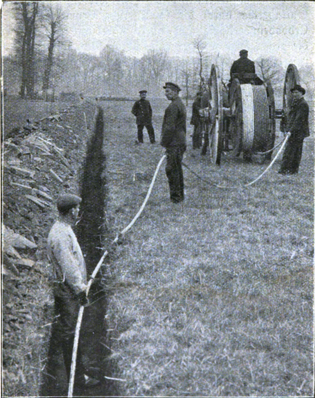
Abb. 11. Legen eines Kabels im Kabelgraben.
