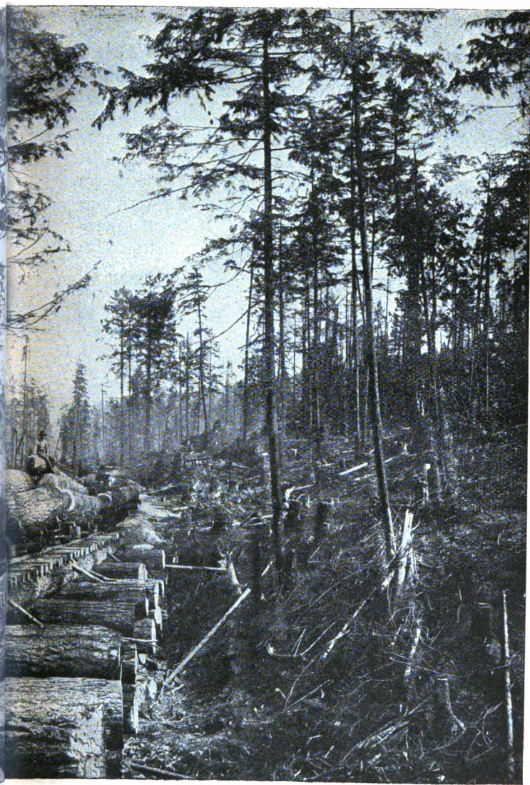
Waldbahn für den Holztransport in Kolumbia.
