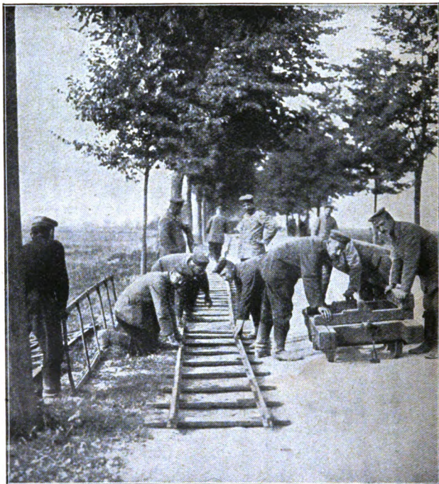
Berliner Landsturm beim Bau einer Feldbahn.
