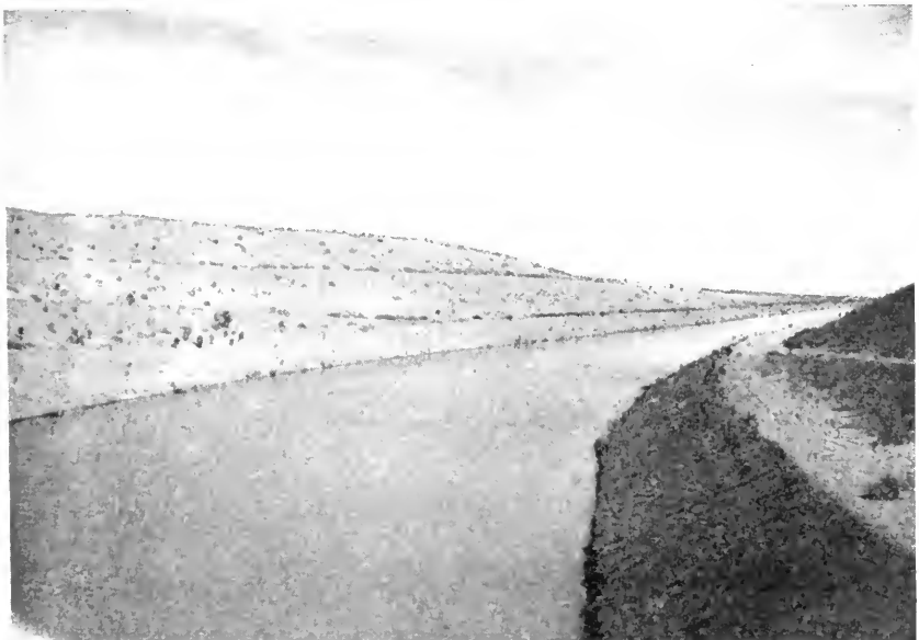
FIG. 75. The All-American Canal. Feb. 1942.
