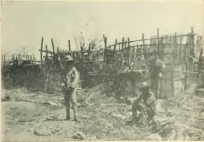
Primera trincheras en Iba.
