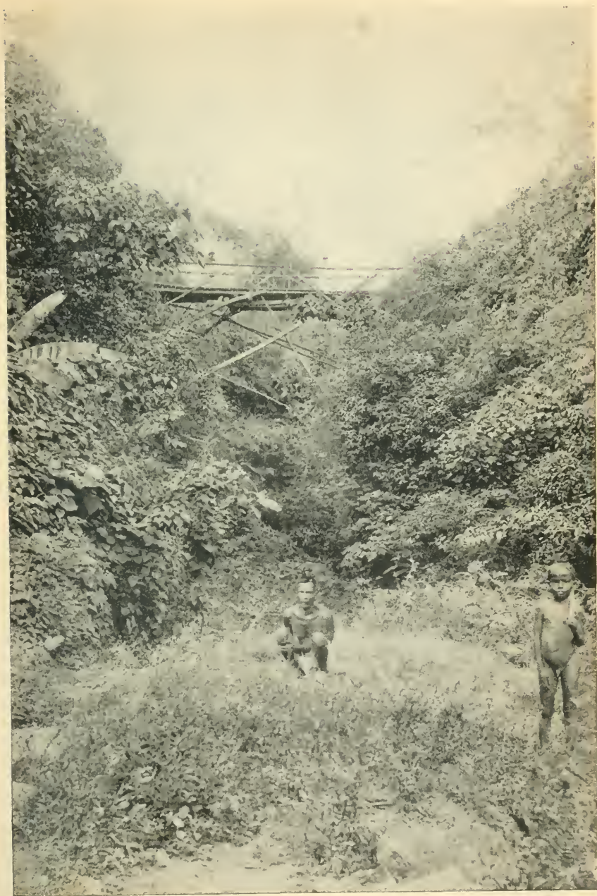
Barranco de Iba y puente construido por la División para atravesarlo.
