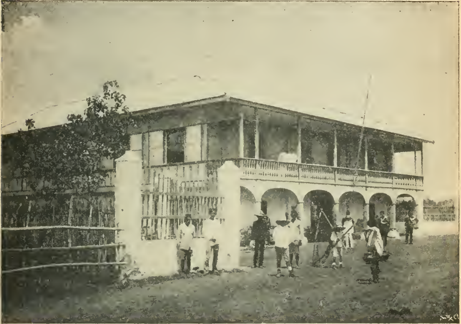
Casa de materiales fuertes en Imus.
