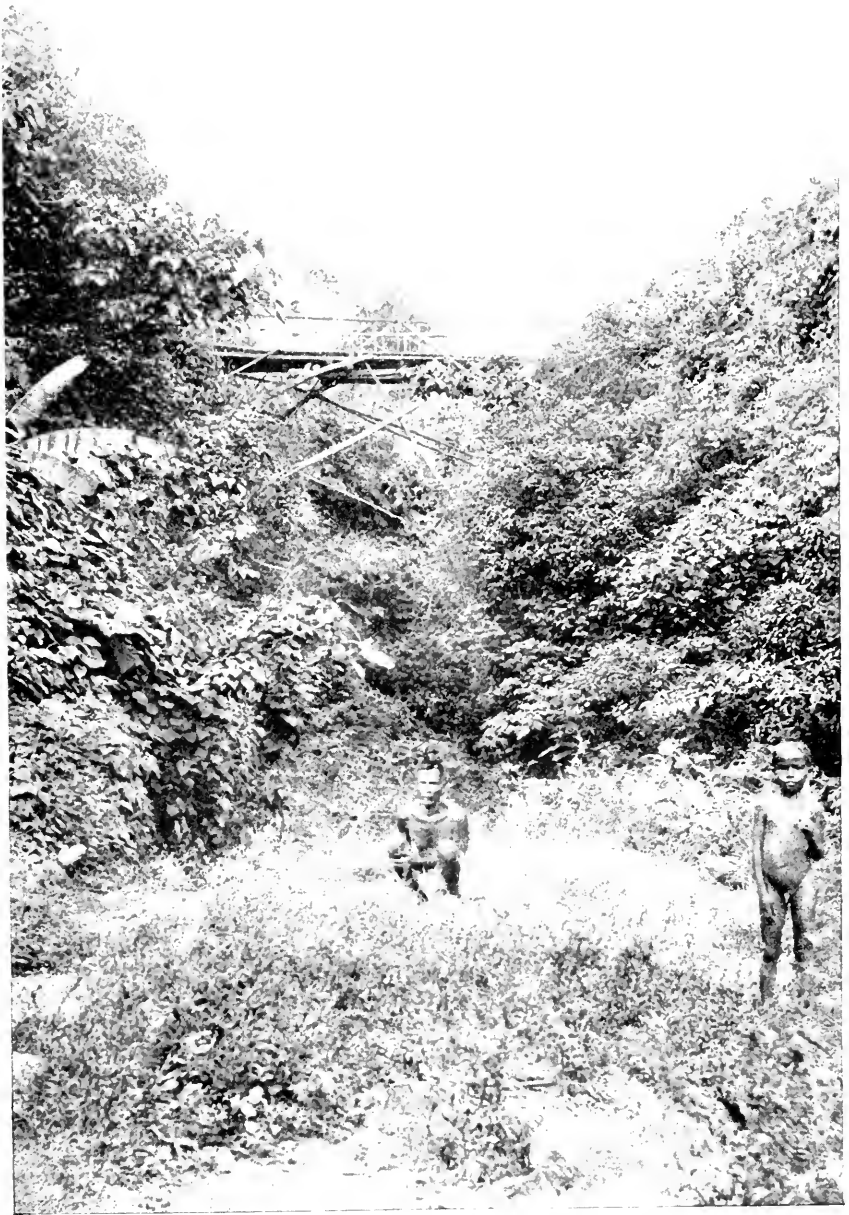
Barranco de Iba y puente construído por la División para atravesarlo.
