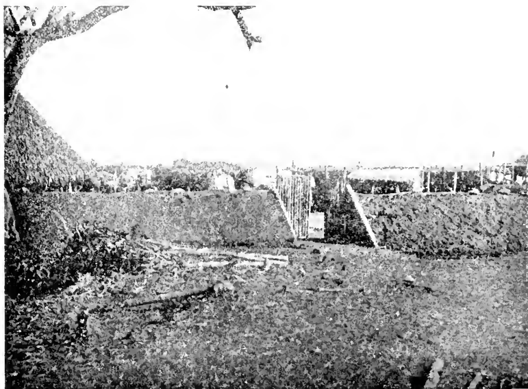
Trinchera en la margen izquierda del Zapote.
