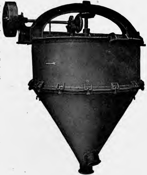
FIG. 9.—Air Separator ( Gebr. Pfeiffer ).
