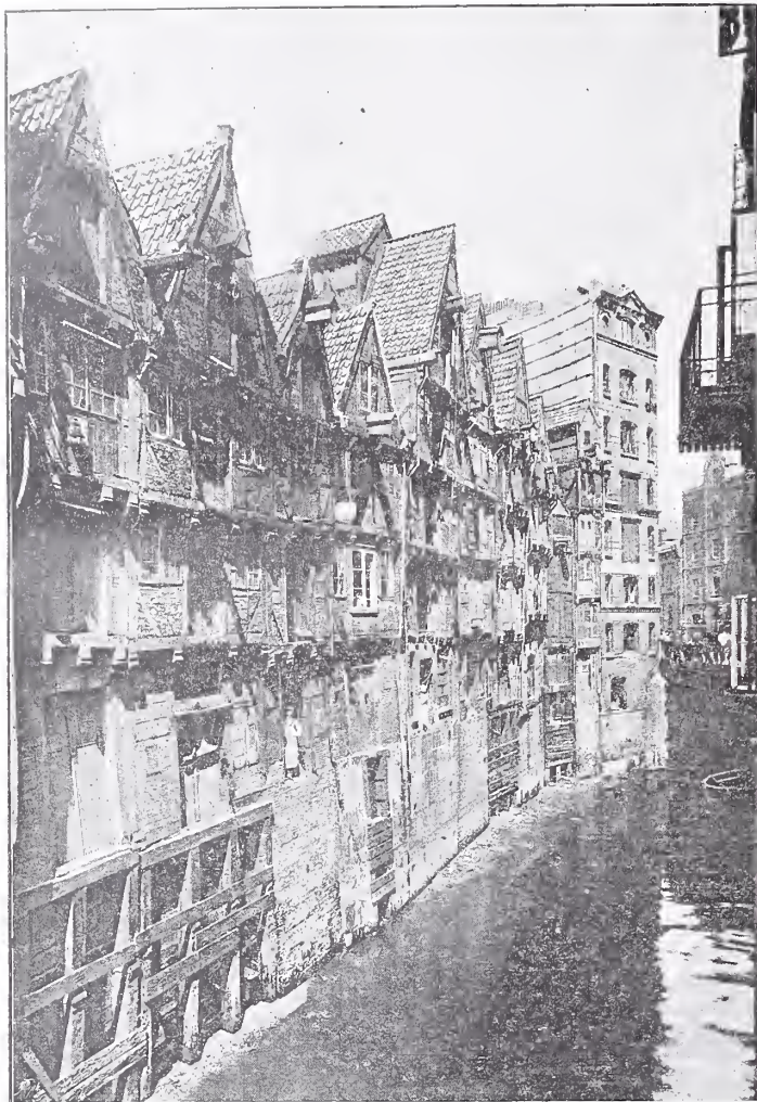
Alte Speicher am Mattentwietenfleth. Aus „Hamburg und seine Bauten“.
