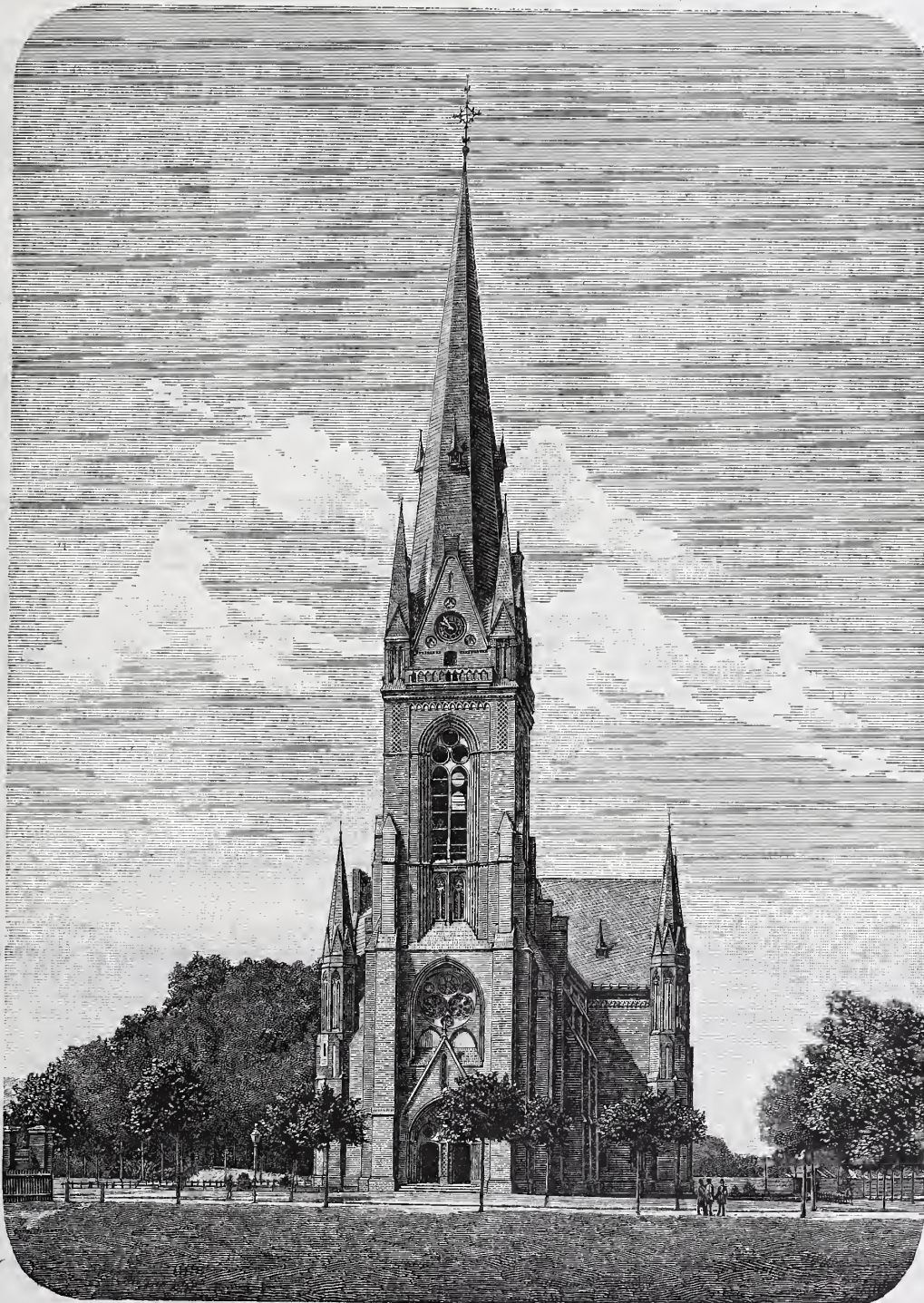
Abb. 3. Ansicht von Osten. Neue evangelische Garnisonkirche in Spandau.
