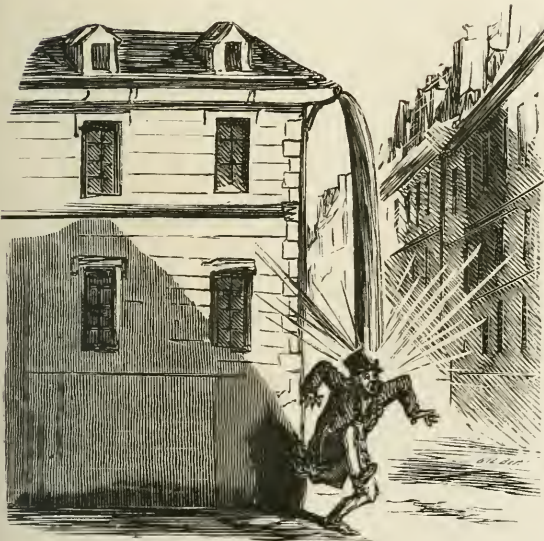
ART. 681. — De l'égout des toits. Comme quoi il ne doit pas être réversible sur la tête d'un tiers.
