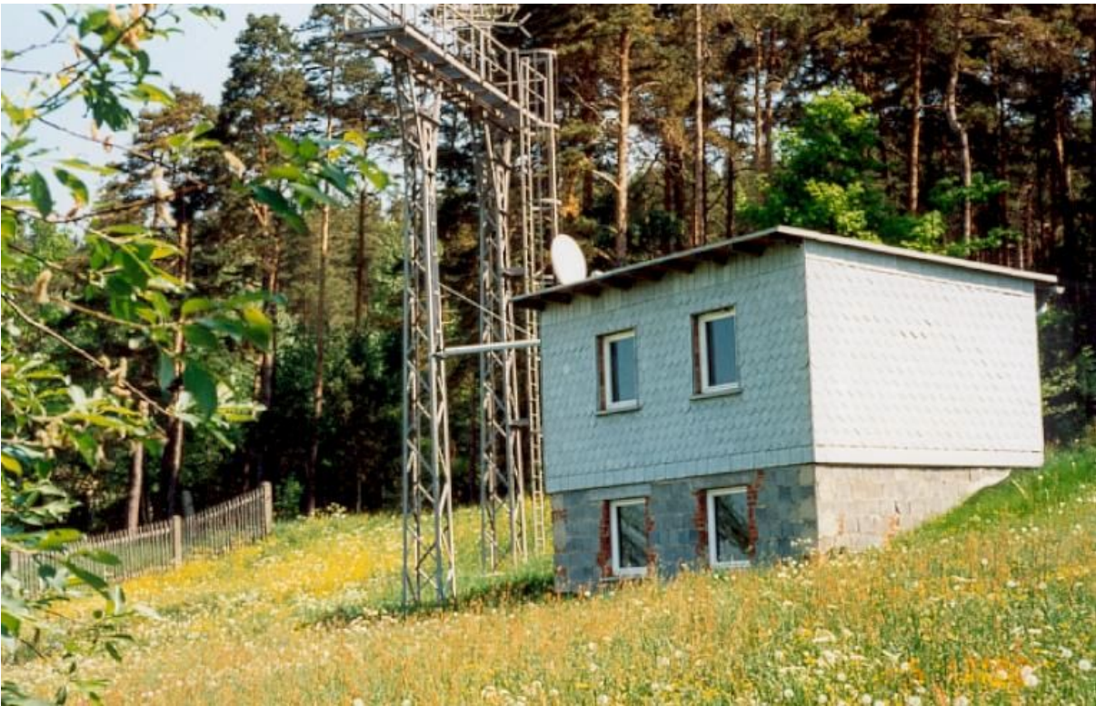
Kopfstation der Antennenanlage, 1993
