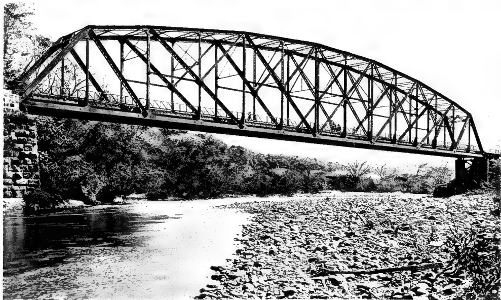
Barranca River Bridge, Port Puntarenas, C. R.
