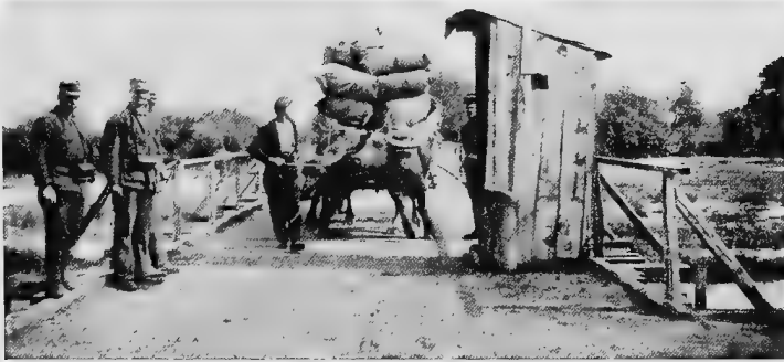
FRONTIER BRIDGE, BISTRITZA RIVER
