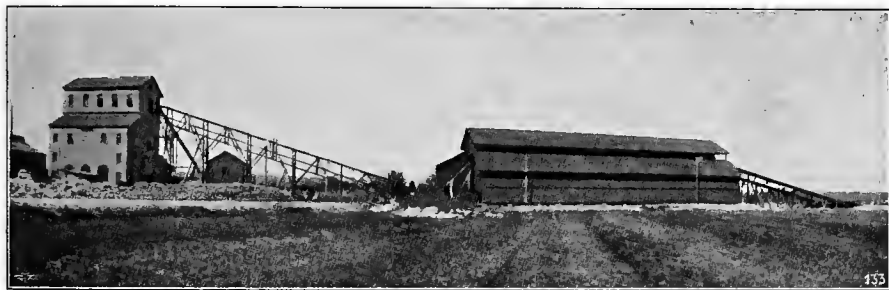
"Jernkontorets Försöksverk" at Trollhättan. — Electric Blast Furnace.
