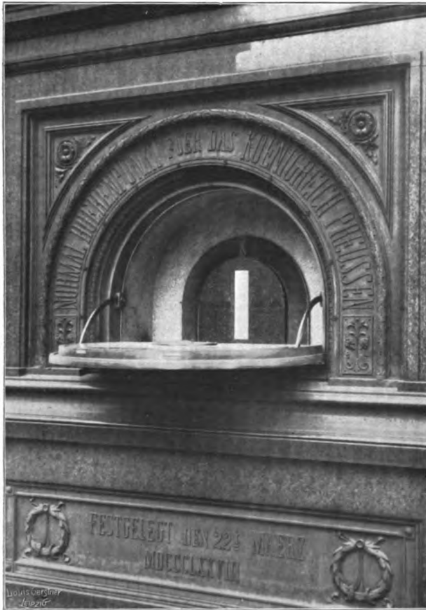
Abbildung 2. Der Normal-Höhenpunkt am Nordpfeiler der Königlichen Sternwarte zu Berlin. Geöffnetes Gehäuse.
