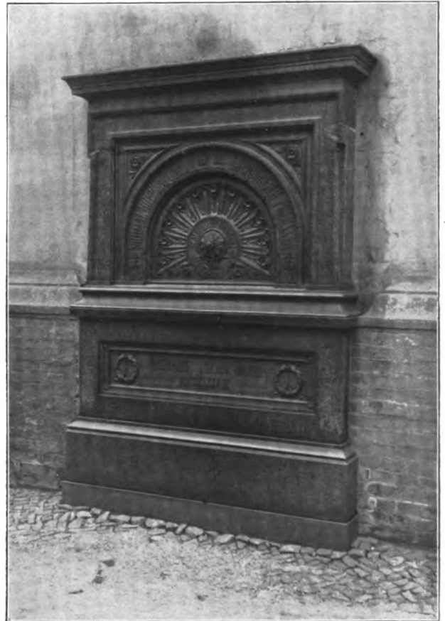
Abbildung 2. Der Normal-Höhenpunkt am Nordpfeiler der Königlichen Sternwarte zu Berlin. Geöffnetes Gehäuse.
