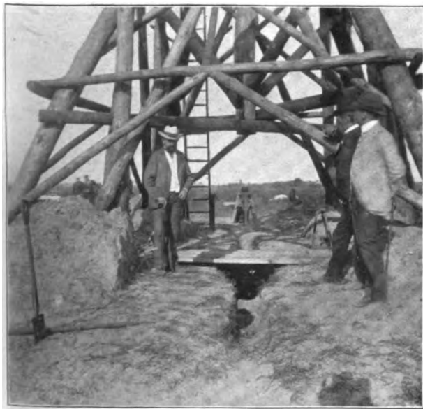
Abbildung 9. Festlegung des nördlichen Basisendpunktes.
