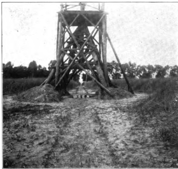
Abbildung 8. Südlicher Endpunkt der Basisstrecke.
