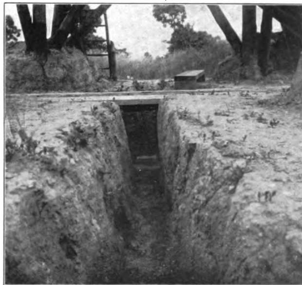
Abbildung 10. Festlegung des südlichen Basisendpunktes.
