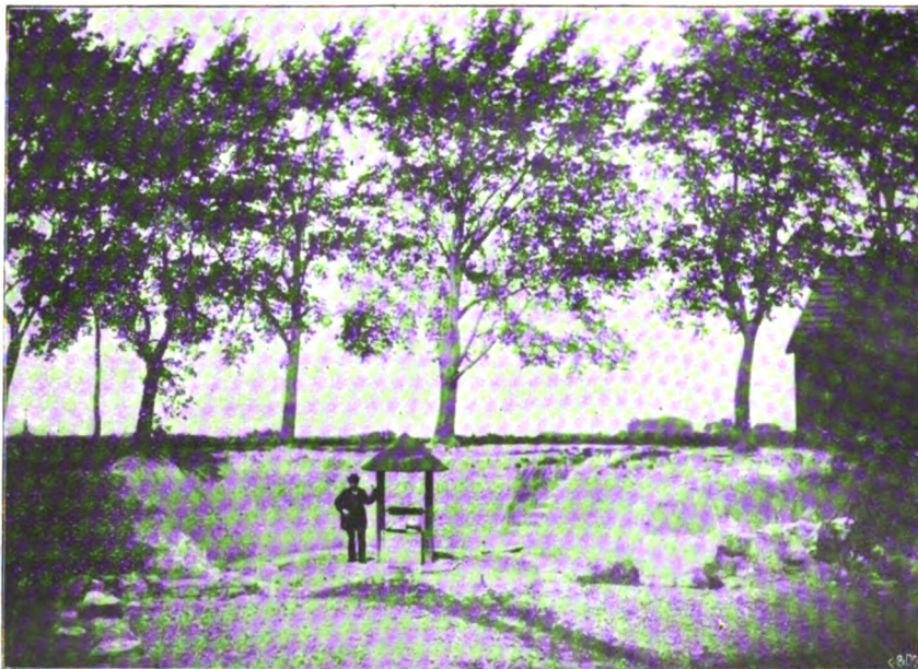
Nördlicher Teil der Uranienburg mit dem Brunnenhäuschen.
