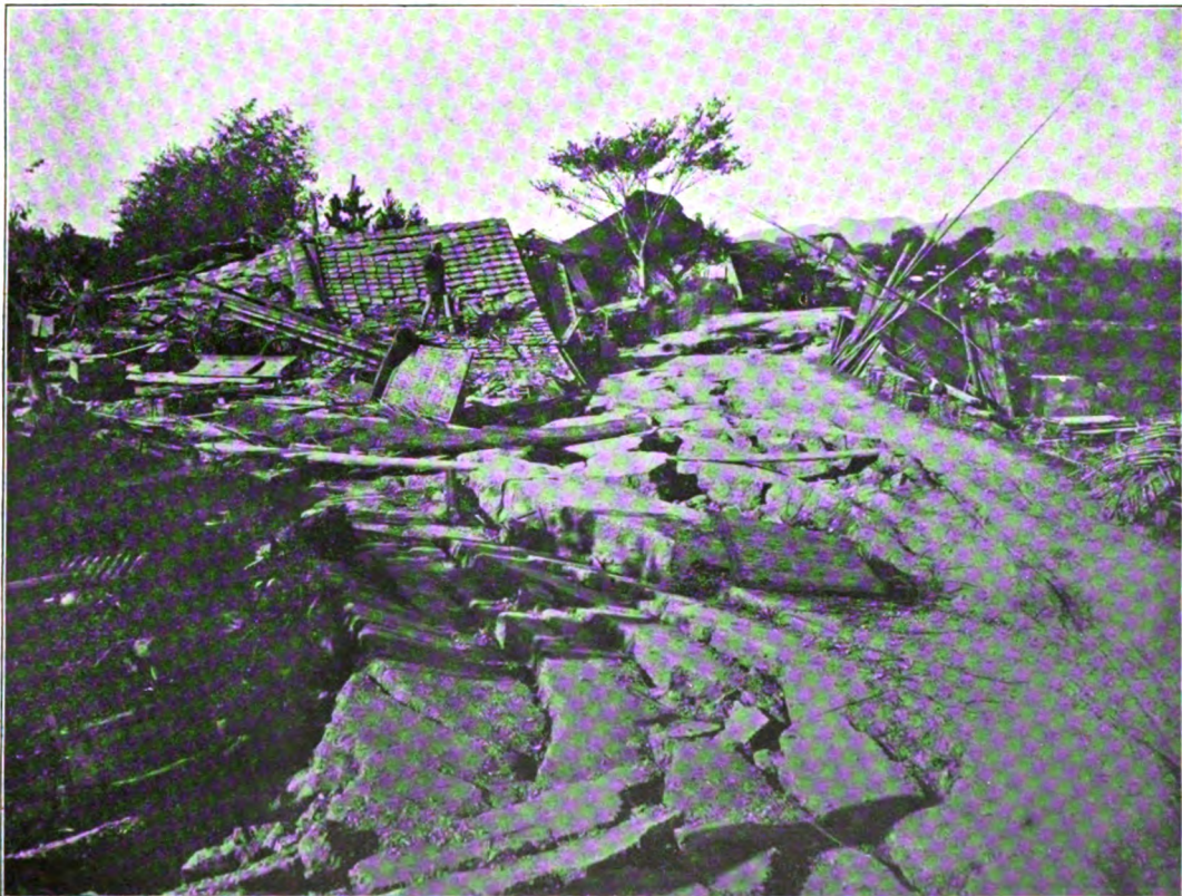
Erdbeben in Zentral-Japan, 1891 Oktober. Hauptherd der Zerstörung, Schollenförmiges Zerbrechen des Alluvialbodens.
