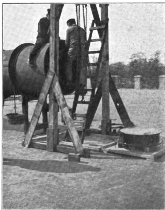
Das Wiedereinsetzen der großen Linse nach Vollendung des Neubaues der Treptow-Sternwarte.
