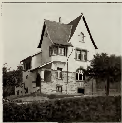
PROF. HEINRICH METZENDORF-BENSHEIM LANDHÄUSER IN BENSHHEIM AN DER HESSISCHEN BERGSTRASSE
