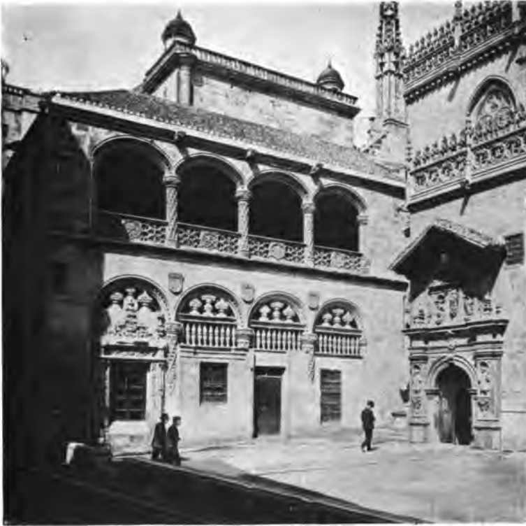
Neue Photogr. Gesellsch.
