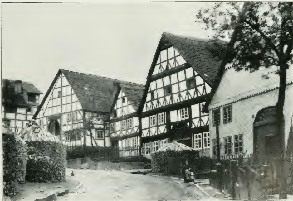
Abb. 62. Straße in Eichershausen.
