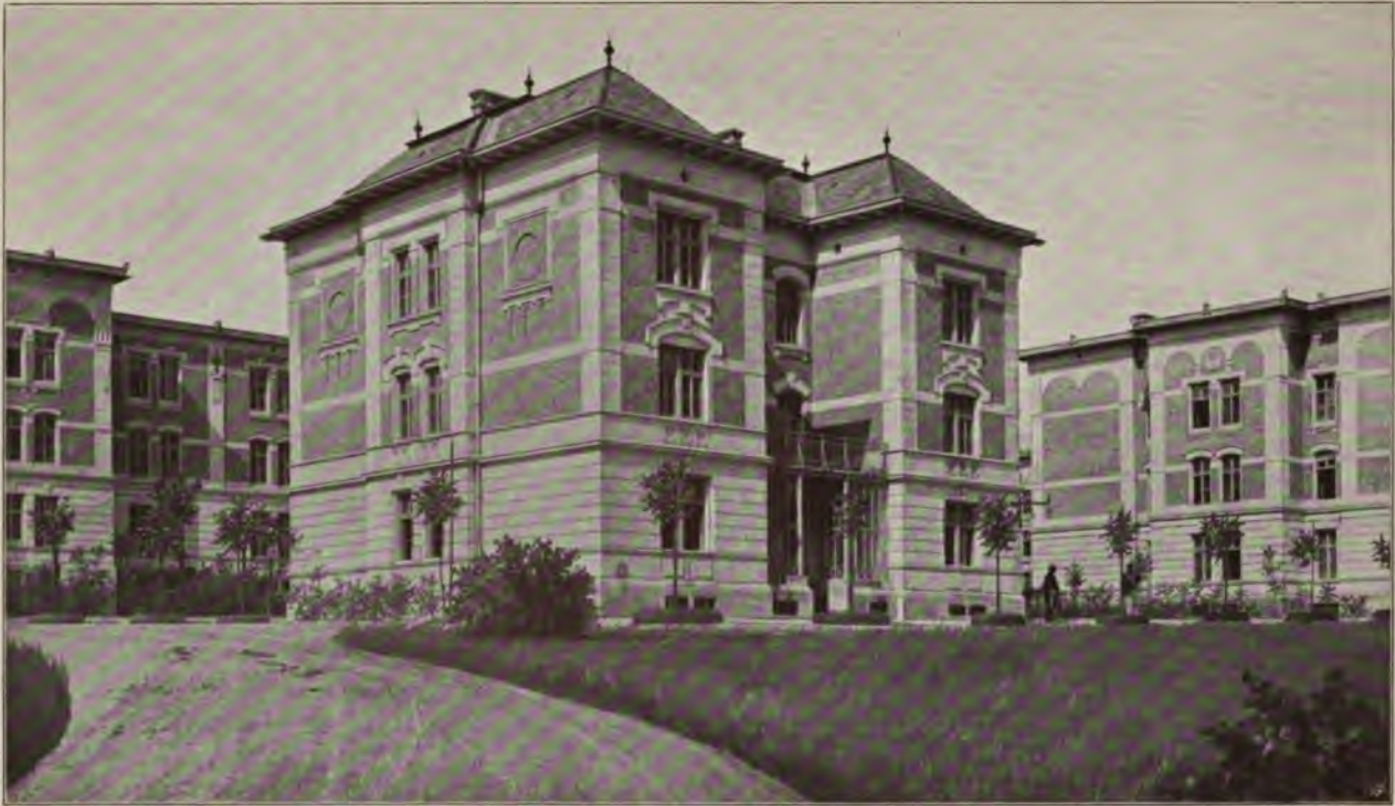
Aufnahms- und Dienergebäude (vordere Ansicht).
