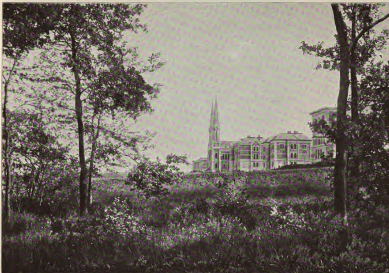
Das Wiener Verforgungsheim (von Norden aus gesehen).
