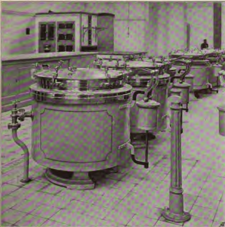
Dampfkochkessel im großen Küchenraum.
