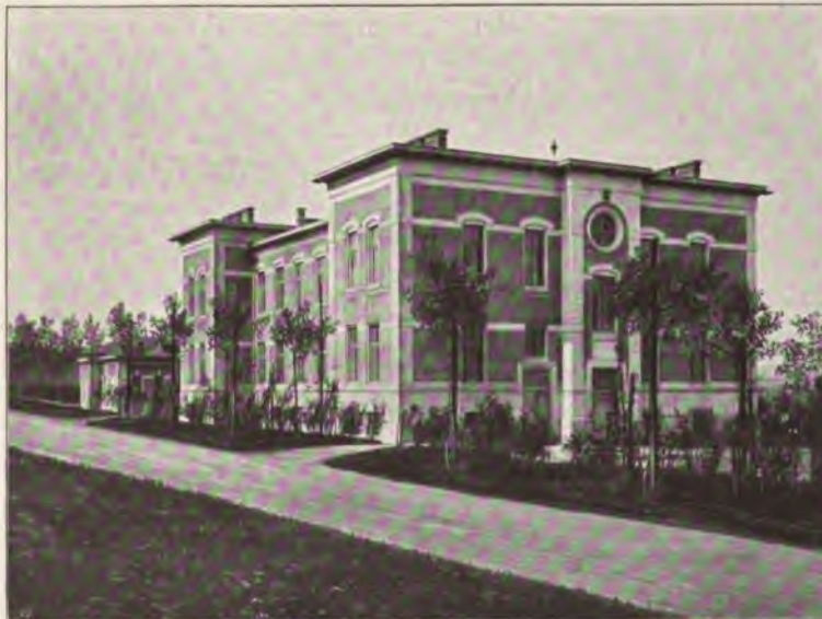
Das Isolierhaus (Seitenansicht).
