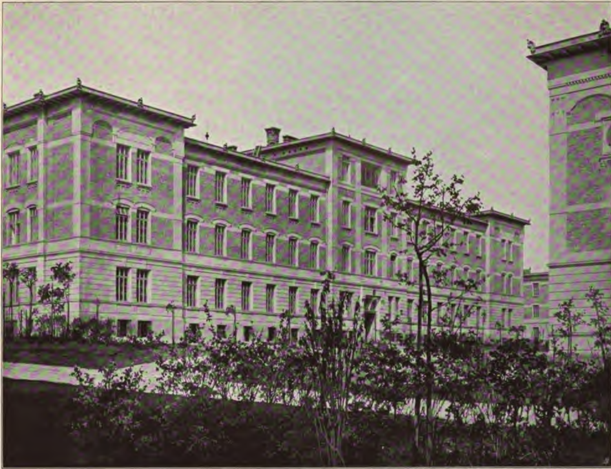
Krankenheim (vordere Ansicht).
