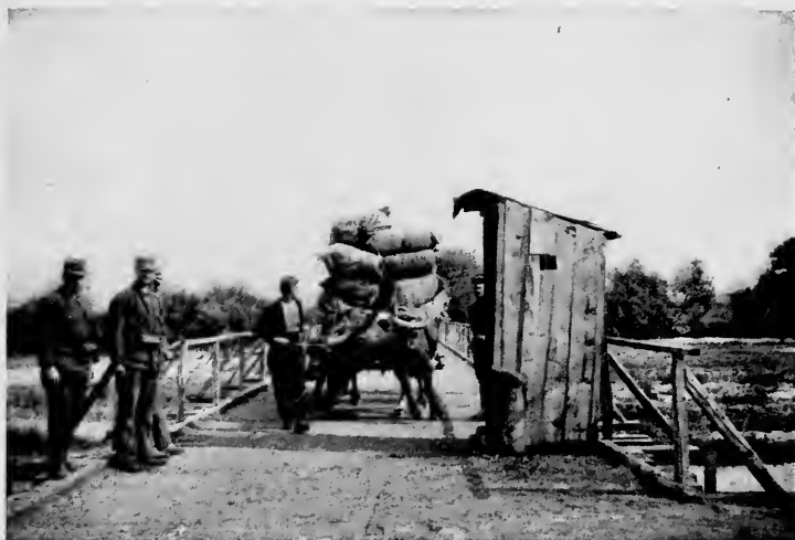
FRONTIER BRIDGE, BISTRITZA RIVER
