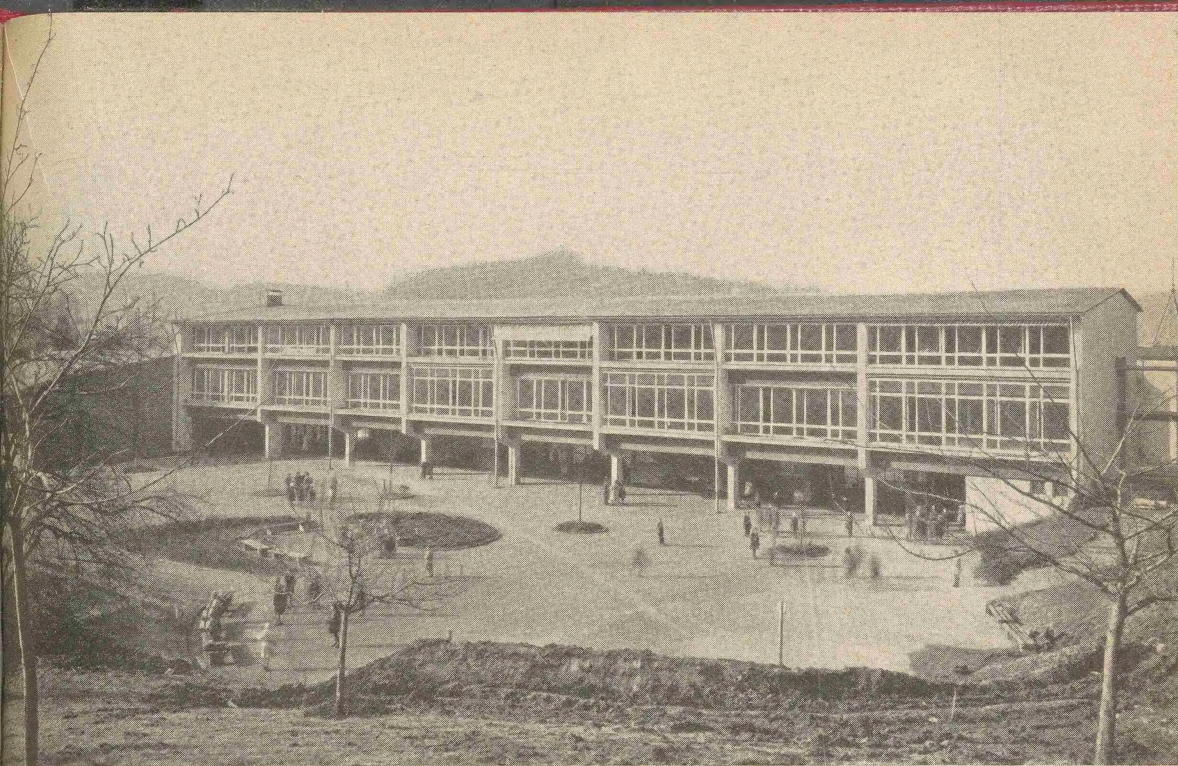
Die 1952 eingeweihte Rauchbeinschule von Süden; Architekt Wolf Irion
