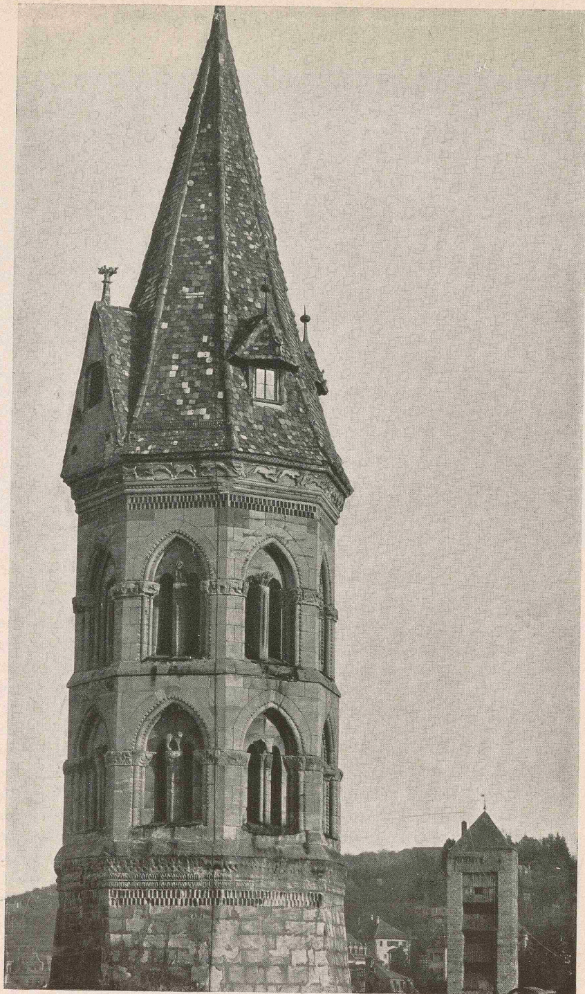
Nordwestseite des Turms
