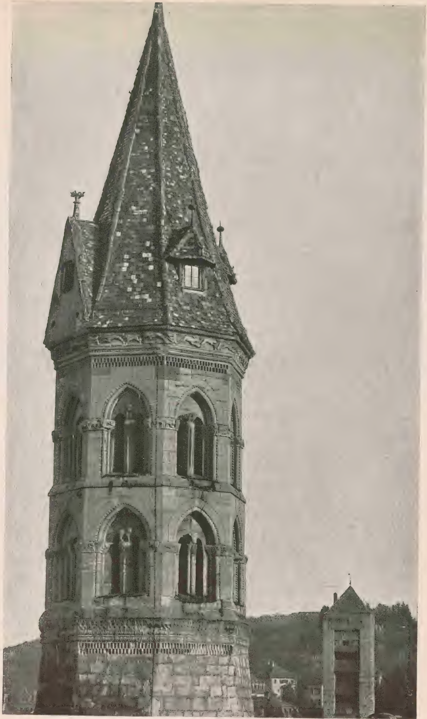
Nordwestseite des Turms
