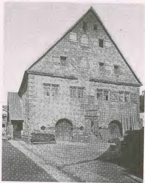
193 Das Schwörhaus der Reichsstadt: die sog. Schmalzgrube, 1589–91
