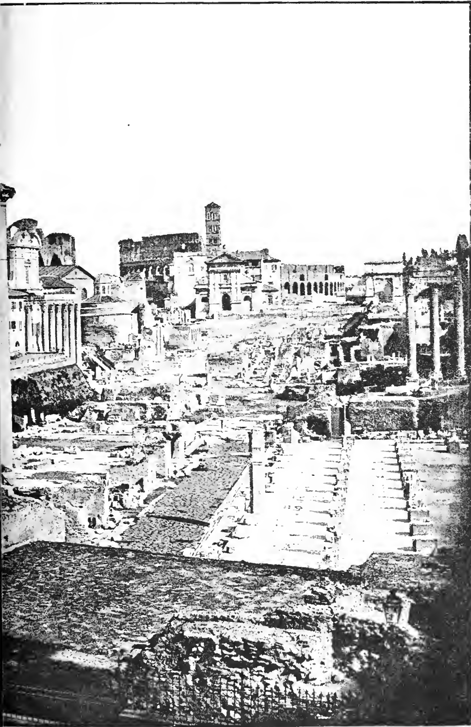
ehen. Links vom Saturnstempel die Seitenwand des Severusbogens; (S. Adriano).
