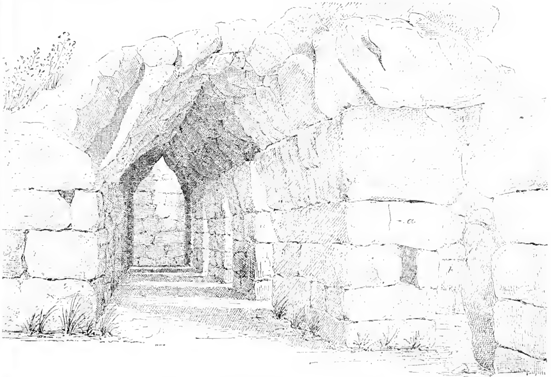
1900 Die Galerie in der Südmauer. (Zu Seite 1810.)
