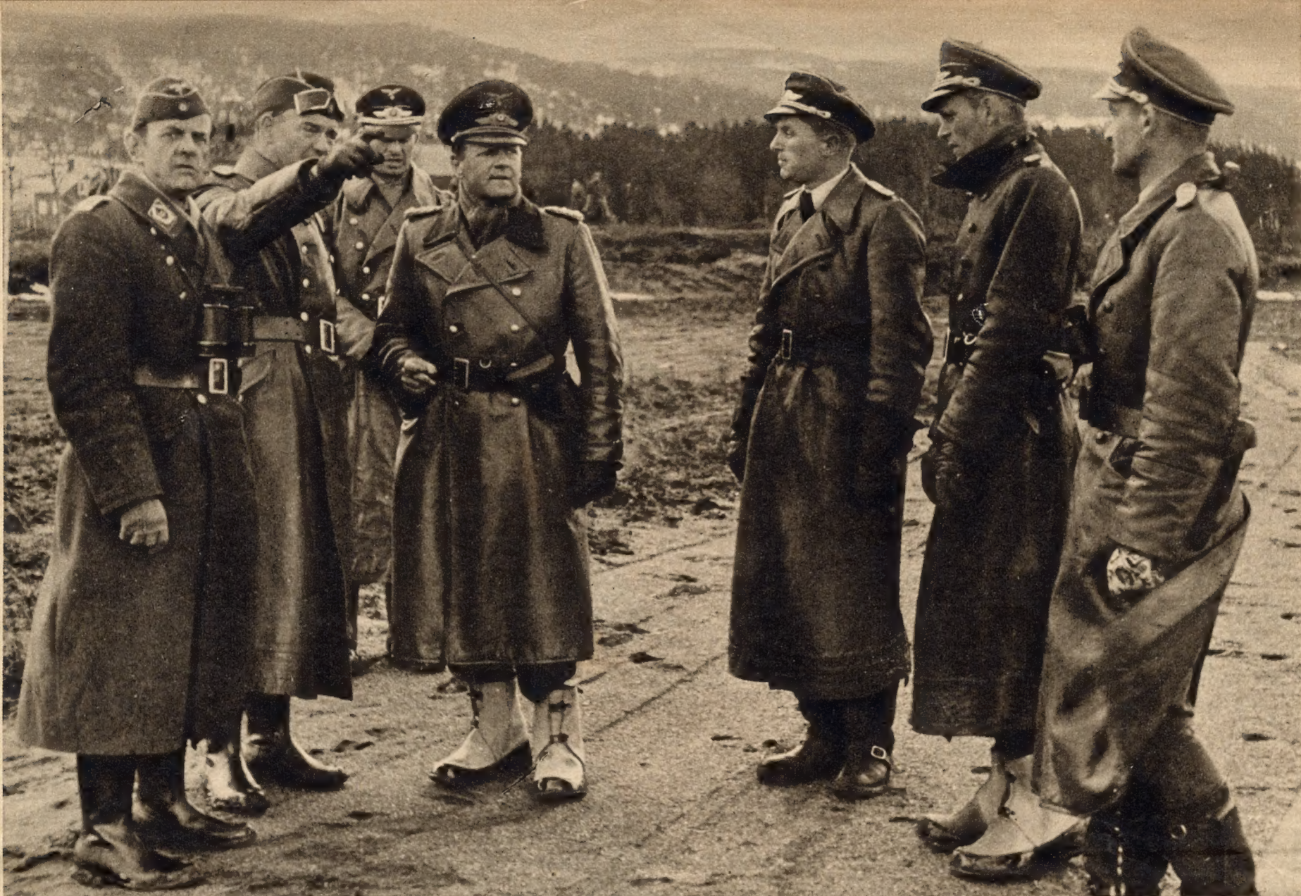
„Dieser Flugplatz muß eine feste Startbahn bekommen.“ Der mit dem Aufbau des Platzes, der durch die Schneeschmelze gelitten hat, beauftragte Offizier erläutert Generaloberst Milch den Stand der Bauarbeiten. Der Generaloberst hat zum Schutz gegen die grundlosen Wege Überstiefel angelegt. Links: Der Fliegerhorstkommandant, rechts: die Staffelnkapitäne der auf dem Platz liegenden Verbände
