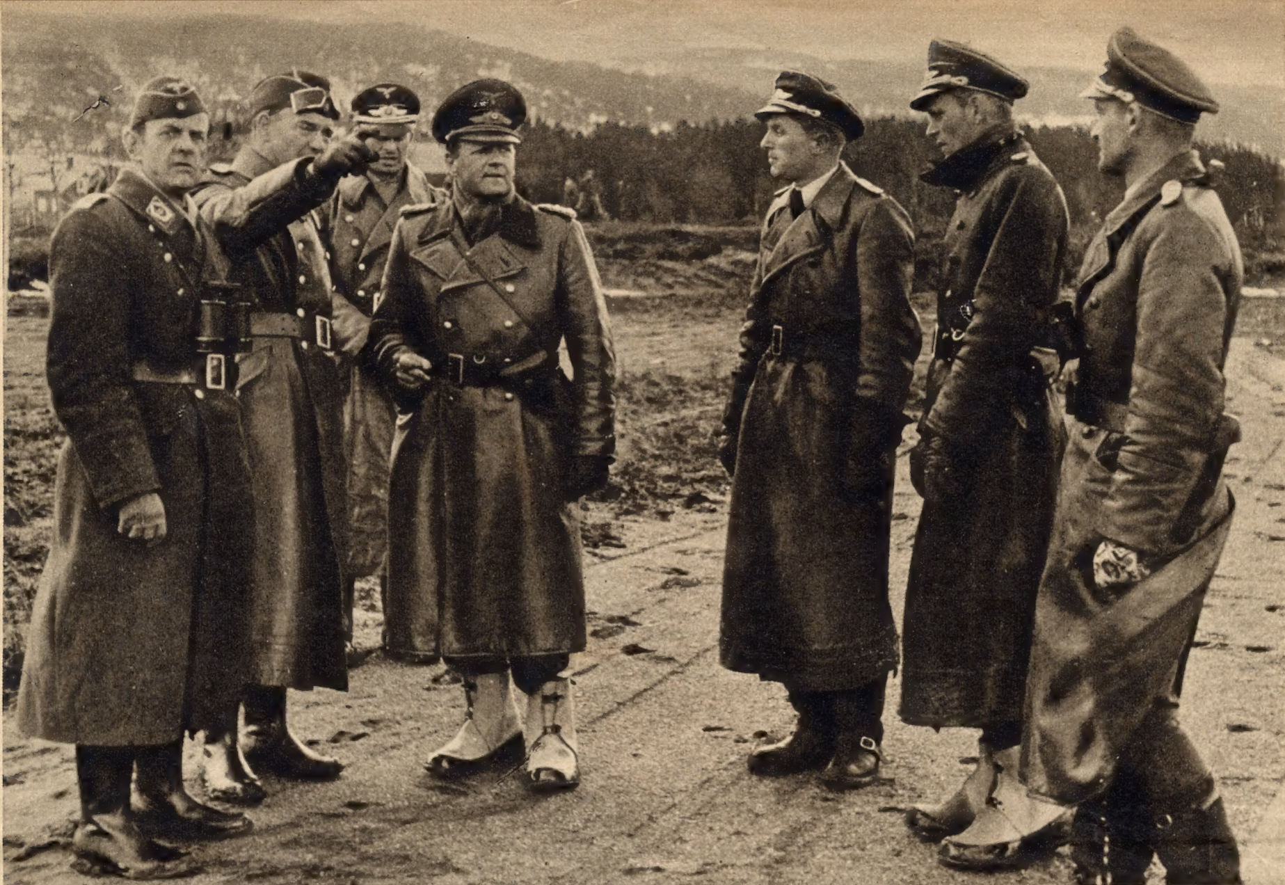
„Dieser Flugplatz muß eine feste Startbahn bekommen.“ Der mit dem Aufbau des Platzes, der durch die Schneeschmelze gelitten hat, beauftragte Offizier erläutert Generaloberst Milch den Stand der Bauarbeiten. Der Generaloberst hat zum Schutz gegen die grundlosen Wege Überstiefel angelegt. Links: Der Fliegerhorstkommandant, rechts: die Staffelnkapitäne der auf dem Platz liegenden Verbände
