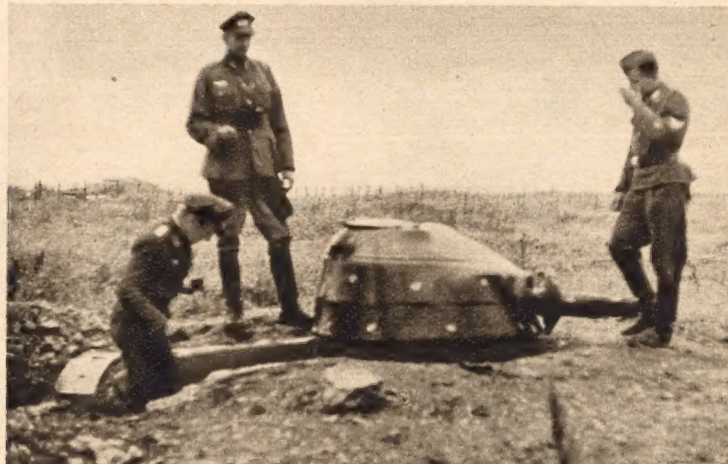
Auf vielen beherrschenden Höhen ist die Maginotlinie durch solche Einmann-Panzer verstärkt. Sie sind mit einem allseitig drehbaren Geschütz bestückt und waren mit nur einem Mann besetzt. Der hier abgebildete Panzer ist unversehrt gefallen, nachdem die umliegenden Werke im Stukafeuer genommen worden waren
