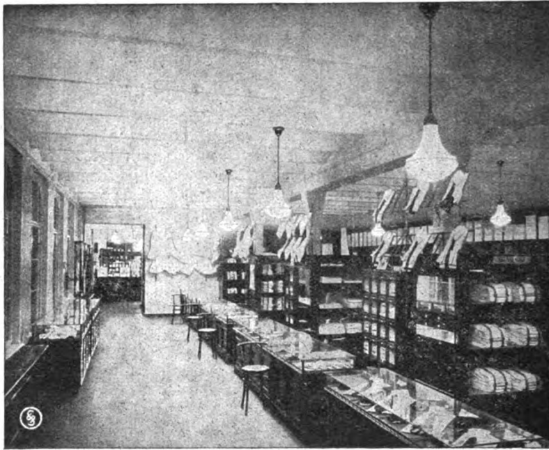
Neuzeitige, halbindirekte Warenhausbeleuchtung
