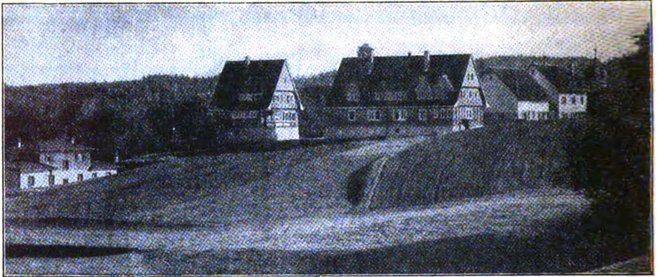
Das Direktions- und Verwaltungsgebäude der G. d. F. in Wüstenrot
