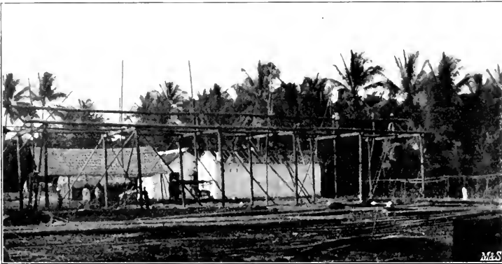
Abbild. 8. Rohbau eines Vorratsschuppens für Häute.
