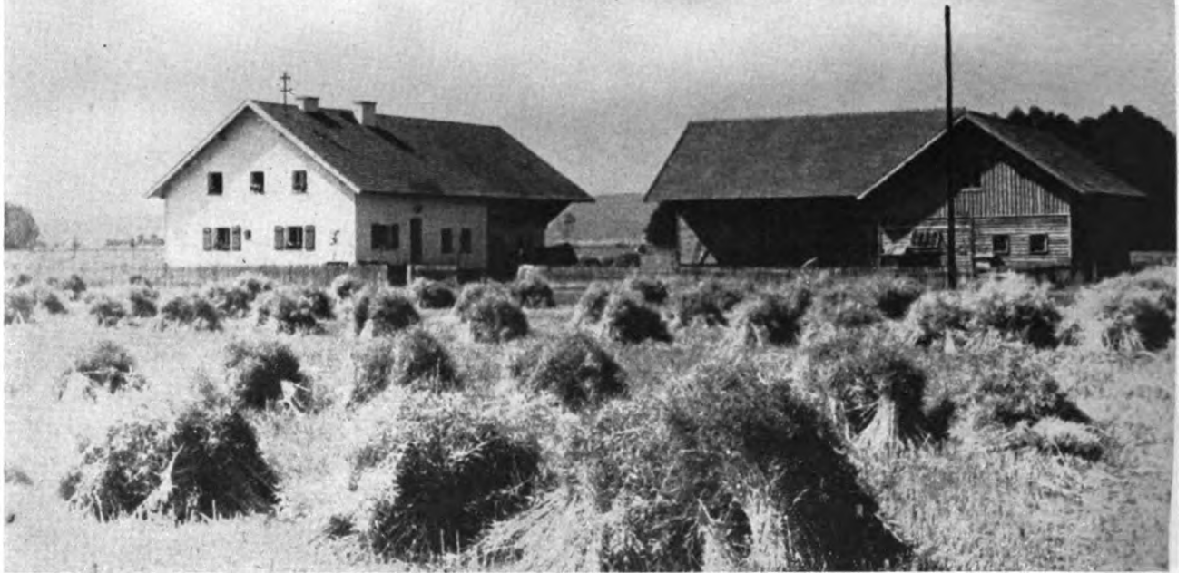
Neuer Bauernhof in Bayern. Wie schon bei den vorstehenden Beispielen, so kommt auch hier die Rückkehr zu landschaftsgebundenem Bauen unter Berücksichtigung der neuzeitlichen Erfordernisse zum Ausdruck.
