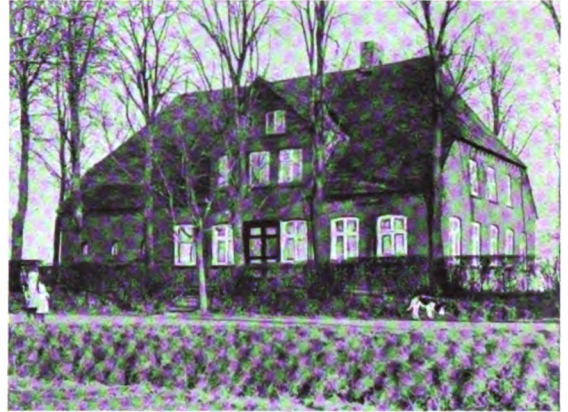
Altbauernhaus in Westerbüttel, errichtet 1877. Baumeister: Jürgen Johannssen (1838—1903)
