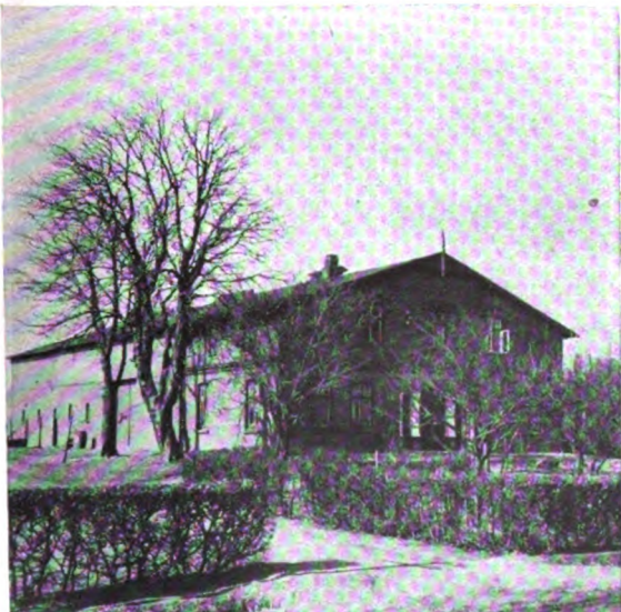
Bauernhaus Rudolf Dethlefs, erbaut 1896. Obwohl von schönem Baumbestand und natürlichem Heckenzaun umgeben, steht das Haus fremd in der Landschaft
