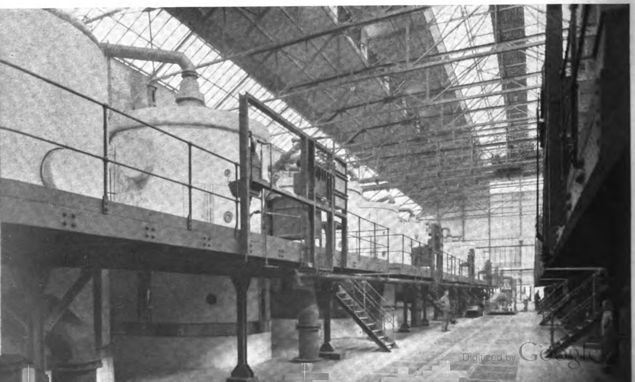
Das untere Bild zeigt eine großzügige Anlage von Verbrennungsöfen
