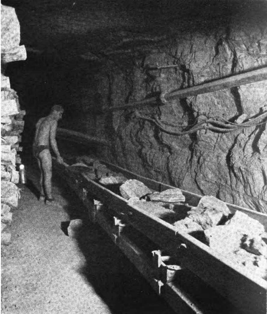
Das Streckenförderband spart Menschenkraft und beschleunigt die Förderung (Bild rechts)
