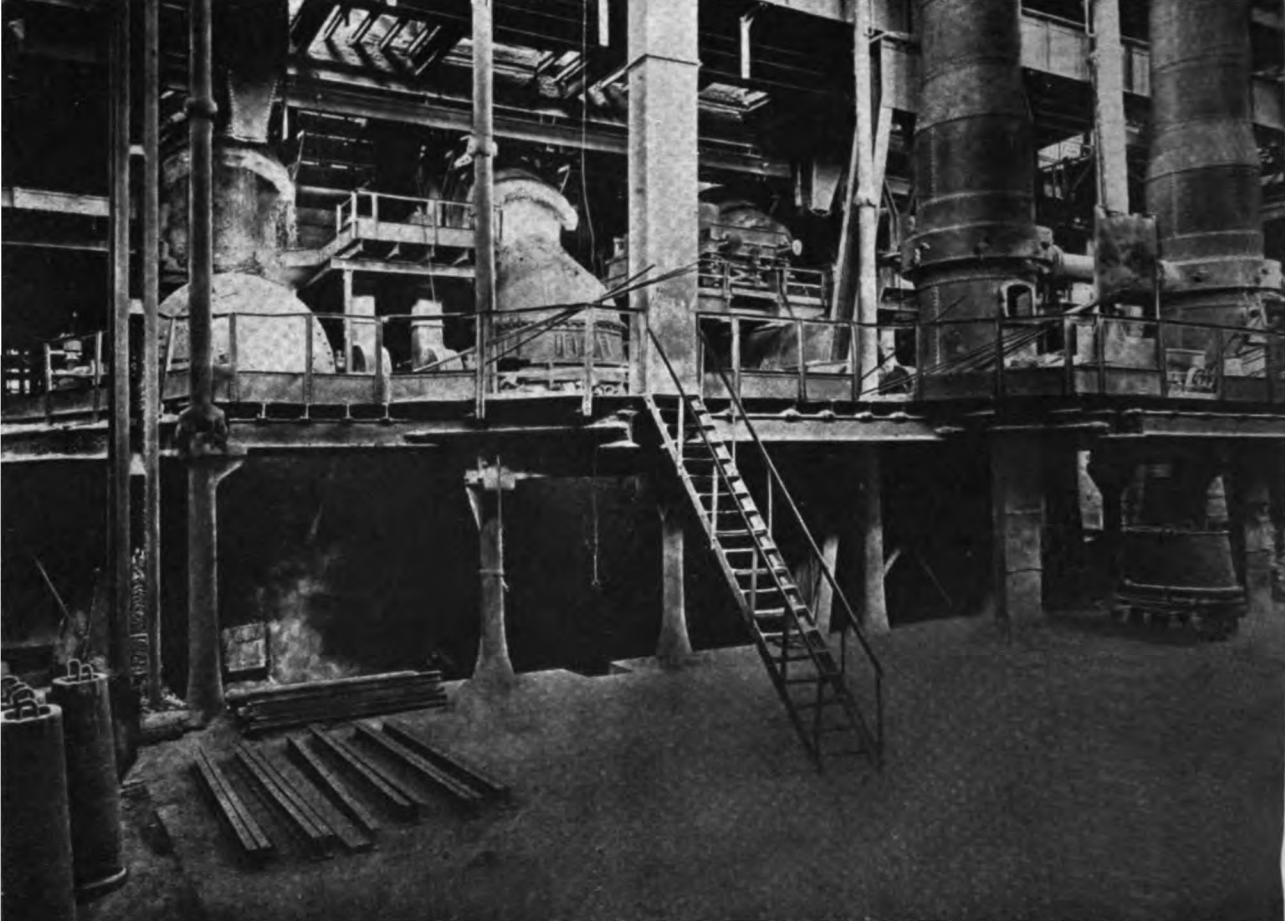
Blick auf eine Bessemeranlage. — Hier fällt der für die Landwirtschaft wichtige Phosphatdünger an
