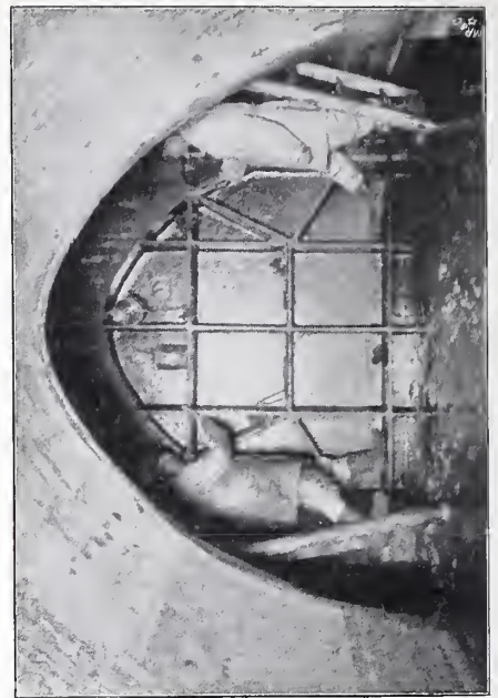
Abbildg. 19. Absperr-Schieber im Kanal in der Schloßstraße (bei der Reinigung).
