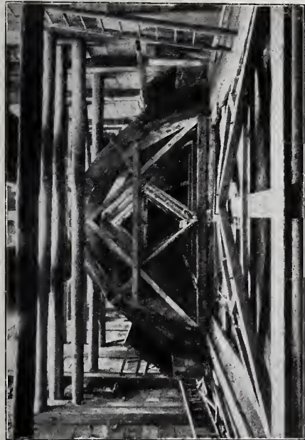
Abbildg. 6. Aussteifung der Baugrube. Lehren für die Einstampfung der Kanäle.
