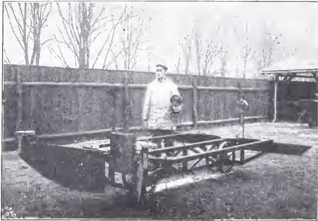
Abbildg. 21. Kanalkahn mit Stauplatte. (Beim Herablassen aus der Kahnkammer.)
