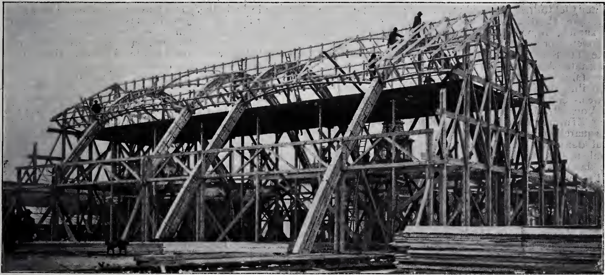
Abbildg. 3. Nördliche Seitenhalle im Bau.
