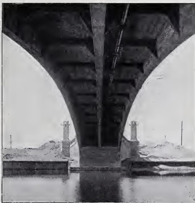
Abbildg. 2 u. 3. Eisenbeton-Bogenbrücke bei Los Angeles in Californien. Aufsicht und Untersicht der Brückenbahn. (Text untenstehend.)
