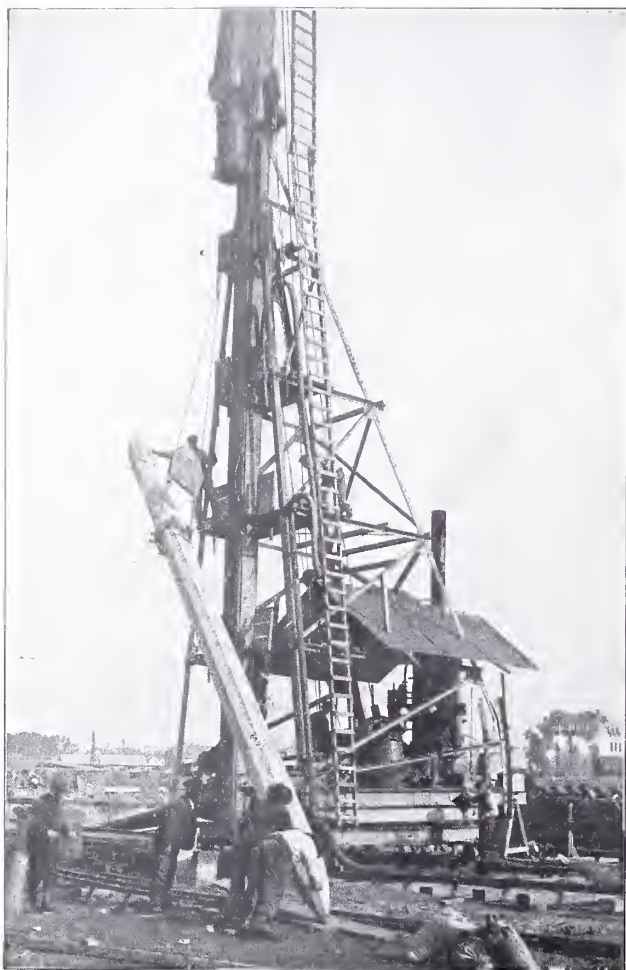
Abbildg. 10. Aufziehen eines Pfahles mit Dampfwinde. Abbildg. 9. Rammbar und Schlaghaube, Spülvorrichtung. Eisenbetonpfähle und ihre Anwendung für die Gründungen im neuen Bahnhof in Metz.
