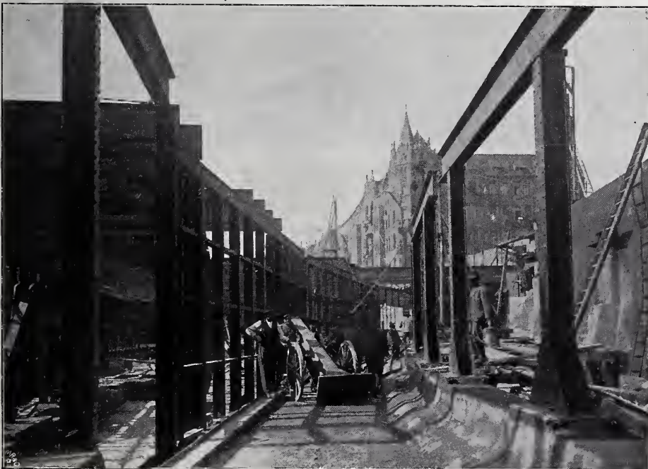
Abbildg. 13. Montage der Fachwerkwände der Unterstation Bahnhof Bismarckstraße.
