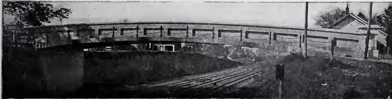
Abbildg. 1. Straßenüberführung in Eisenbeton in Memphis, Tenn. Ansicht des Bauwerkes. Spw. rd. 31 m.
