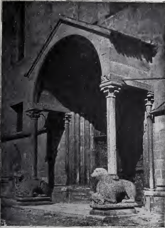
Pfarrkirche in Bozen, Portal. Photograph Aufnahme Fritz Gratl in Innsbruck
