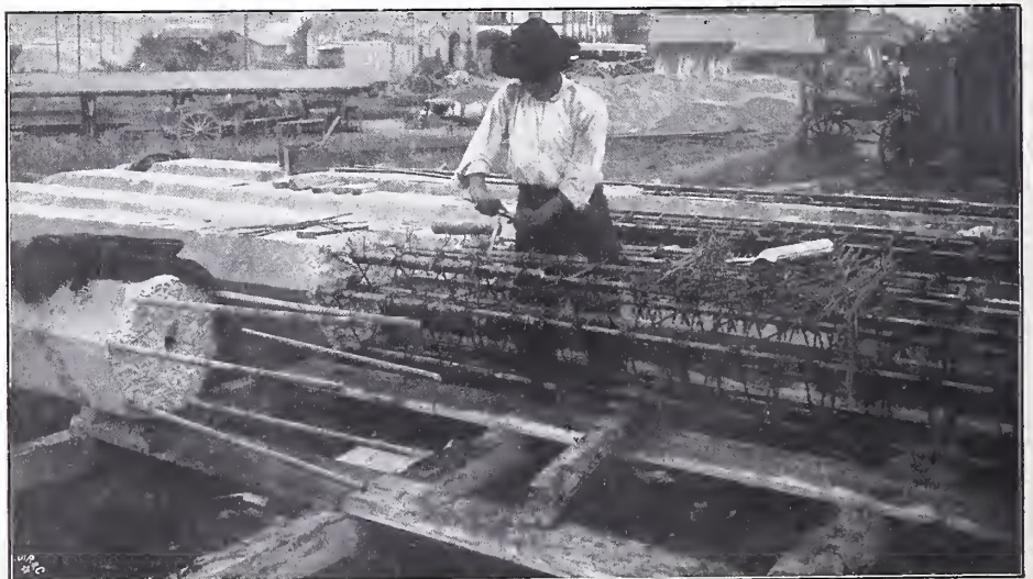
Abbildung 7. Verlängerung von Eisenbetonpfählen.
