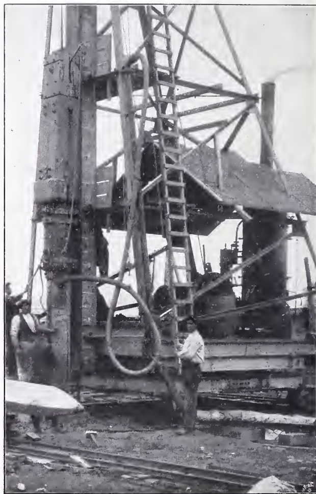
Abbildg. 10. Aufziehen eines Pfahles mit Dampfwinde. Abbildg. 9. Rammbar und Schlaghaube, Spülvorrichtung. Eisenbetonpfähle und ihre Anwendung für die Gründungen im neuen Bahnhof in Metz.
