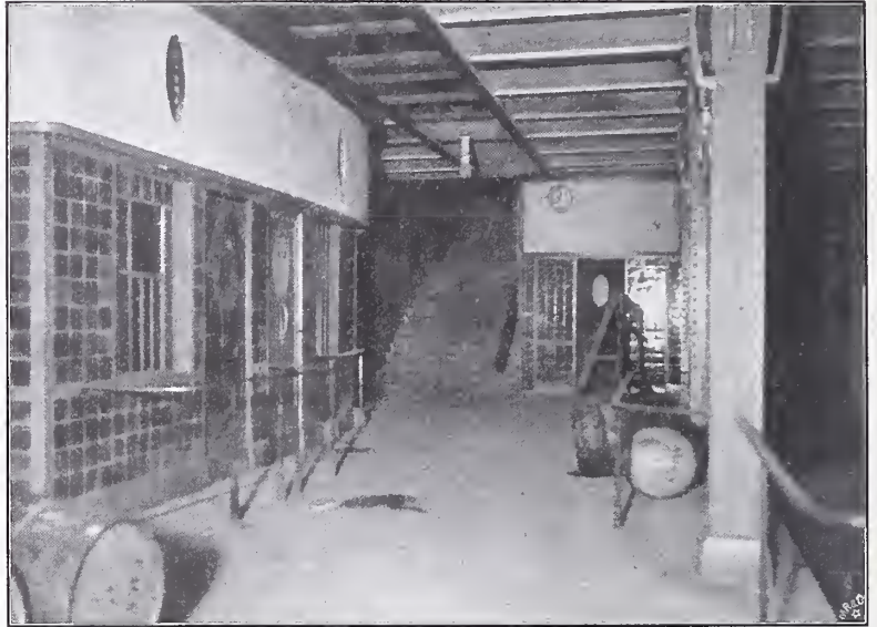
Abbildung 14. Blick auf die Eingangstreppe und die Fahrkartenausgabe.
