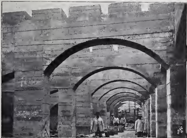
Abbildg. 4. Unterbau des Rieslers der Wasserwerke in Breslau.
