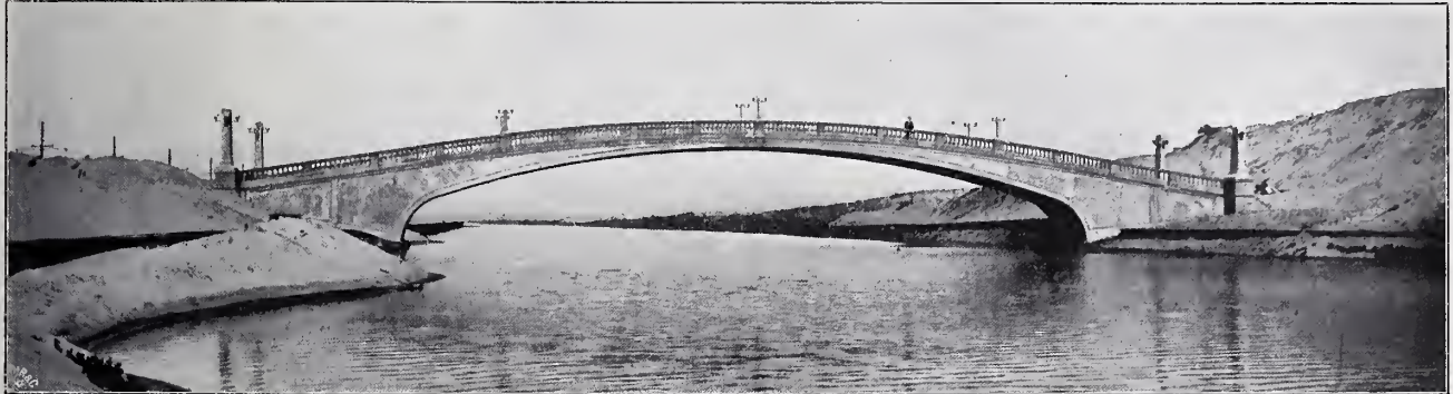
Abbildg. 1. Eisenbeton-Bogenbrücke bei Los Angeles in Californien. (Text S. 51.)
