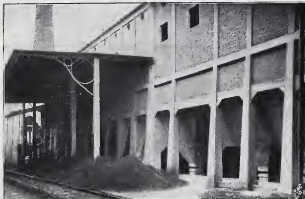
Abbildg. 7. Portlandzement-Silo in Groschwitz.
