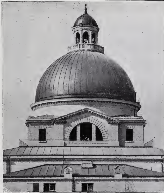
Abbildung 1. Gesamtansicht des Kuppelaufbaues. Arch.: Geh. Ob.-Brt. Mellinger in München.
