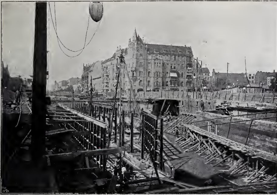
Abbildg. 12. Die Unterstation während der Aufstellung der Eisenkonstruktion.
