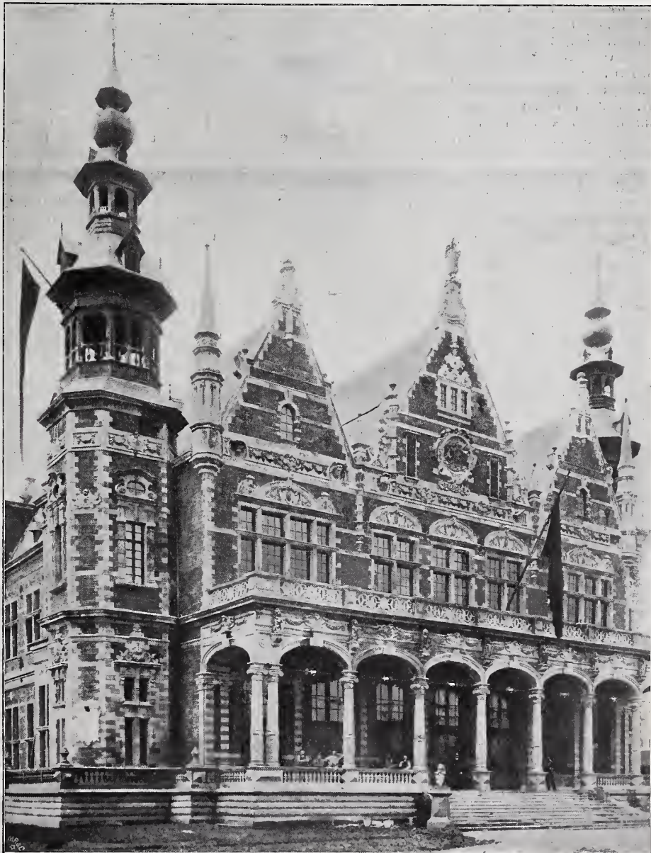
Ausstellungsgebäude des belgischen Staates. Architekt: Henry Vaes.
