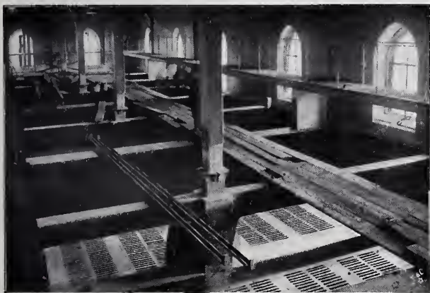
Abbildg. 5. Rieslerkammer mit Eisenbetonrosten.
