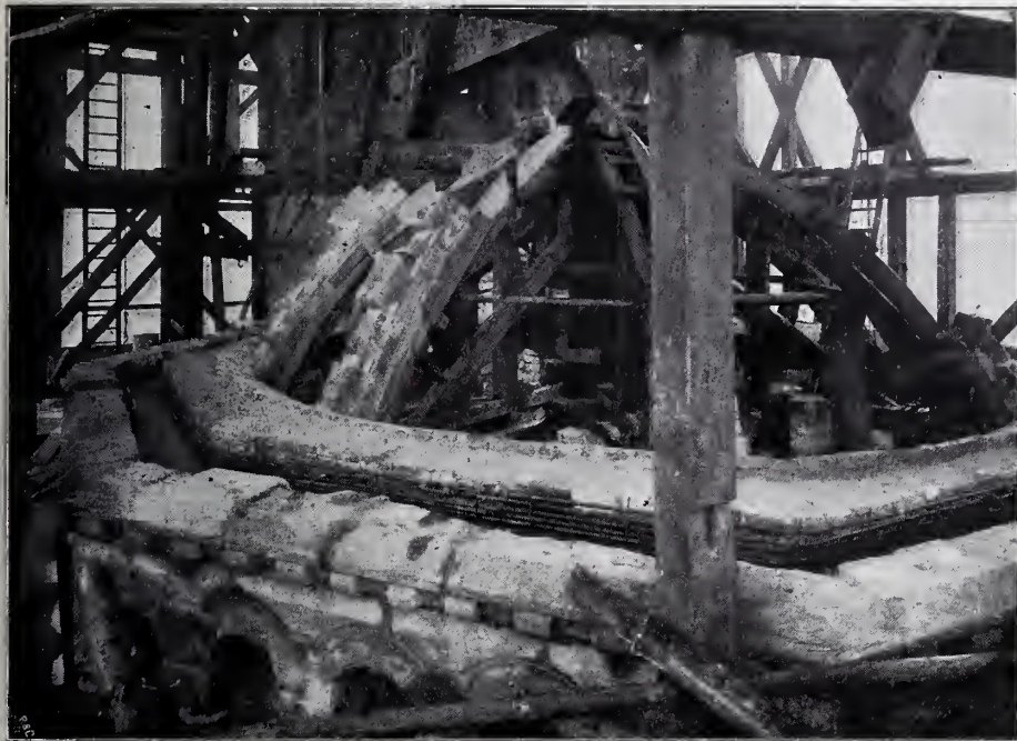
Abbildg. 9. Wiederaufbau der westlichen Vierungskuppel. Verankerung in Dachhöhe.
