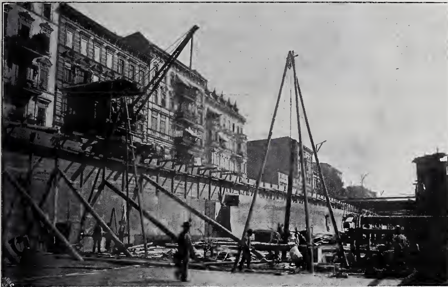
Abb. 11. Entfernung der Brunnen für die Wasserhaltung nach Ausführung des unteren Tunnelprofils.
