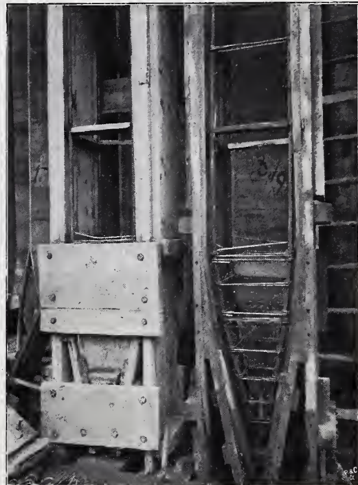
Abbildung 5. In Hamburg angewandte ältere Pfahlspitze. Herstellung der Pfähle in stehender Form.
