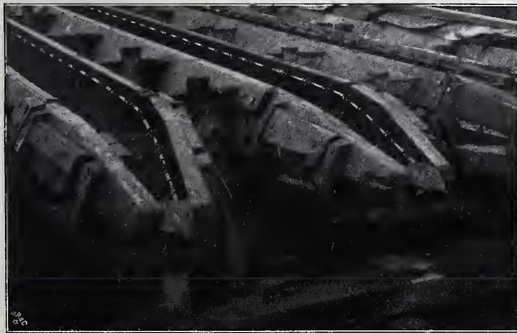
Abbildung 3. Fertige Pfahlgerippe in der Schalung. Für liegende Herstellung.
