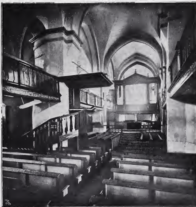
Abbildg. 7. Inneres vor dem Erneuerungsbau.
