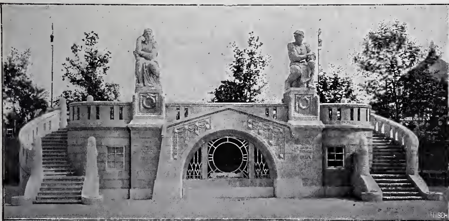
Abbildg. 2. Kunststeinfassade des Pumpenhauses. Ausführung E. Schwenk in Ulm a. D.
