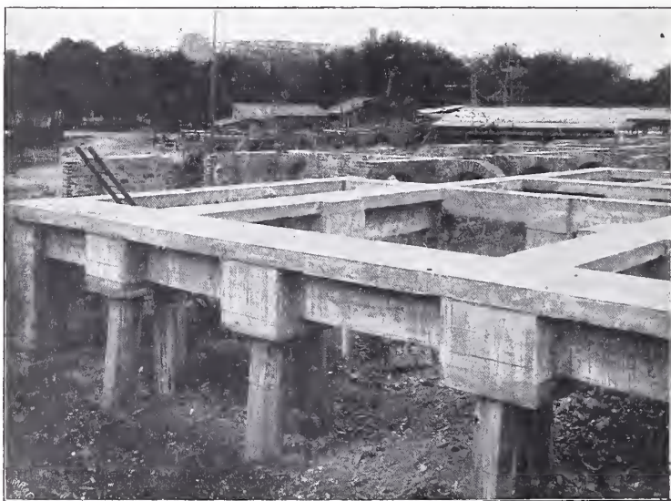
Abbildg. 8. Zur Aufnahme des aufgehenden Mauerwerkes fertiges Eisenbeton-Bankett auf Eisenbetonpfählen (Bahnhofs-Dienstgebäude).
