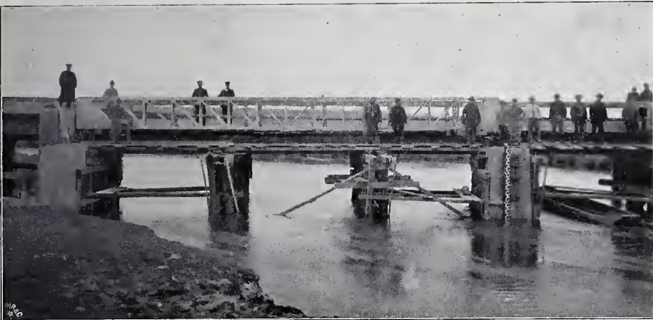
Abbildg. 10. Straßenbrücke mit Visintiniträgern über die Prosna bei Boguslaw.
