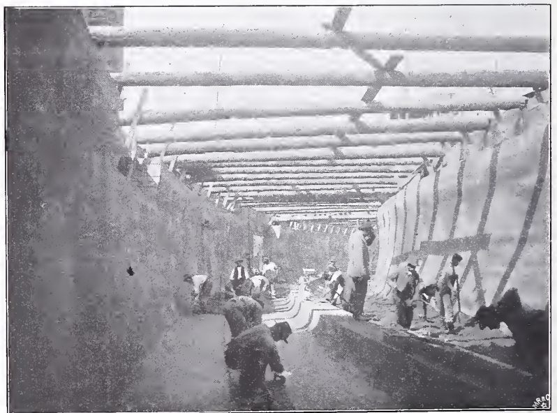
Abbildung 10. Fertigstellung der Sohle mit Entwässerungsrinne. Die Erweiterung der Berliner Untergrundbahn nach dem Westen.
