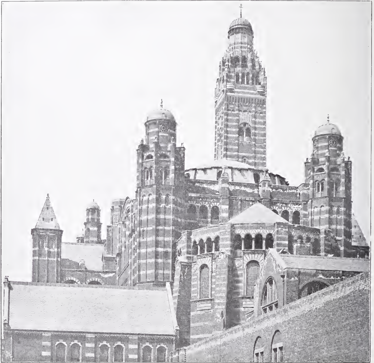
Die neue römisch-katholische Westminster-Kathedrale in London. Choransicht. Architekt: John Francis Bentley †.
