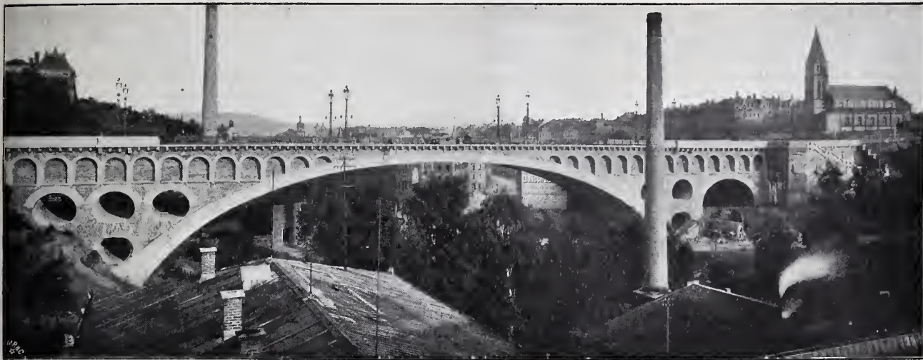
Brücke über das Syratal in Plauen i. V. Spannweite 90 m, Pfeil 18 m.
