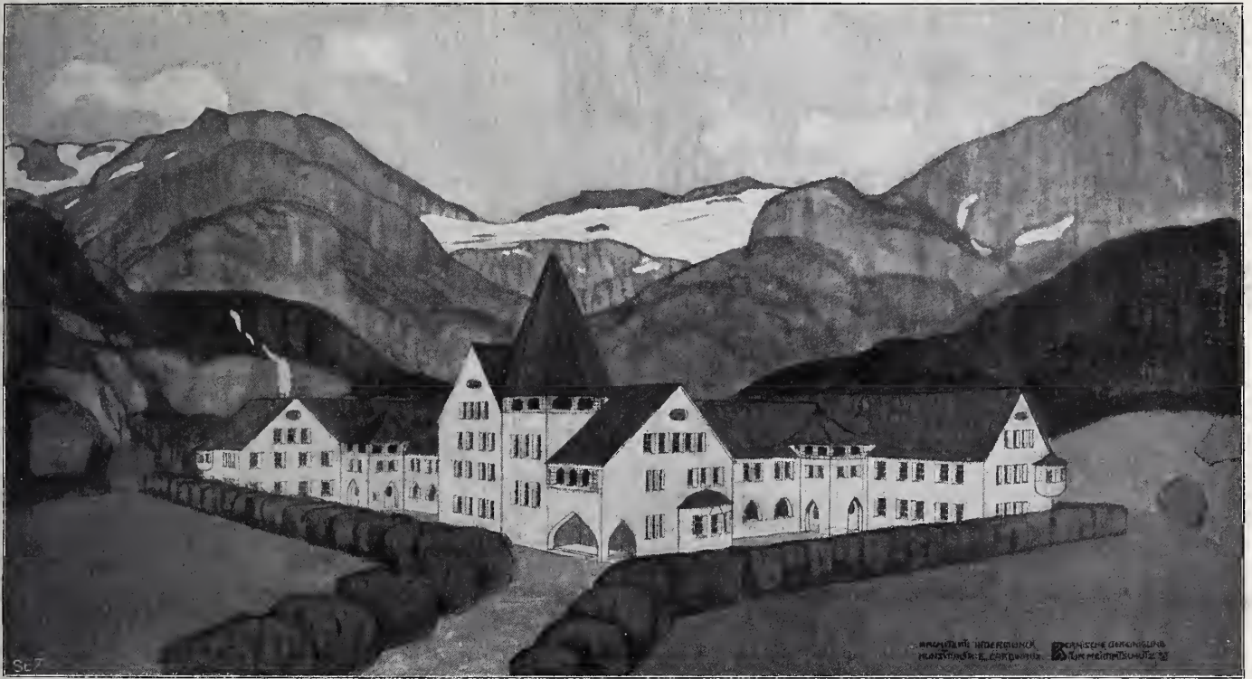
Haupt-Ansicht mit Haupteingang.
