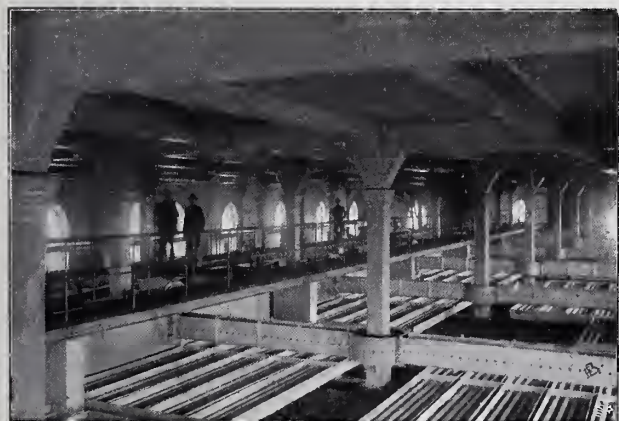
Abbildg. 6. Obergeschoß des Rieslers in Breslau.
