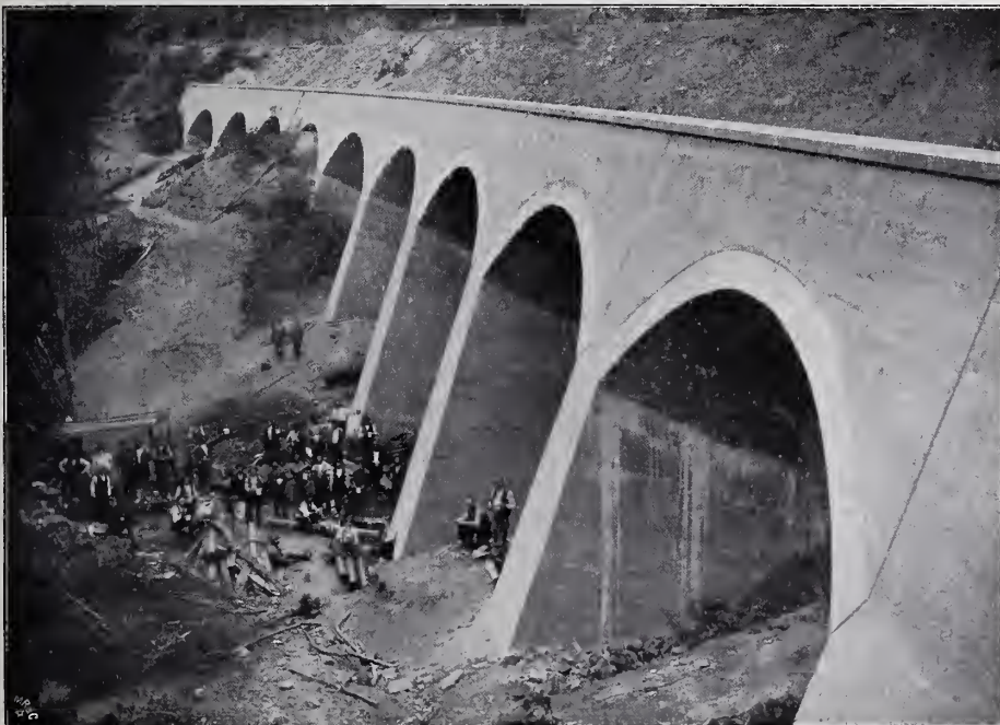
Abbildg. 1. Stampfbeton-Futtermauer im Zuge der Eisenbahnlinie Hirschberg—Lähn.
