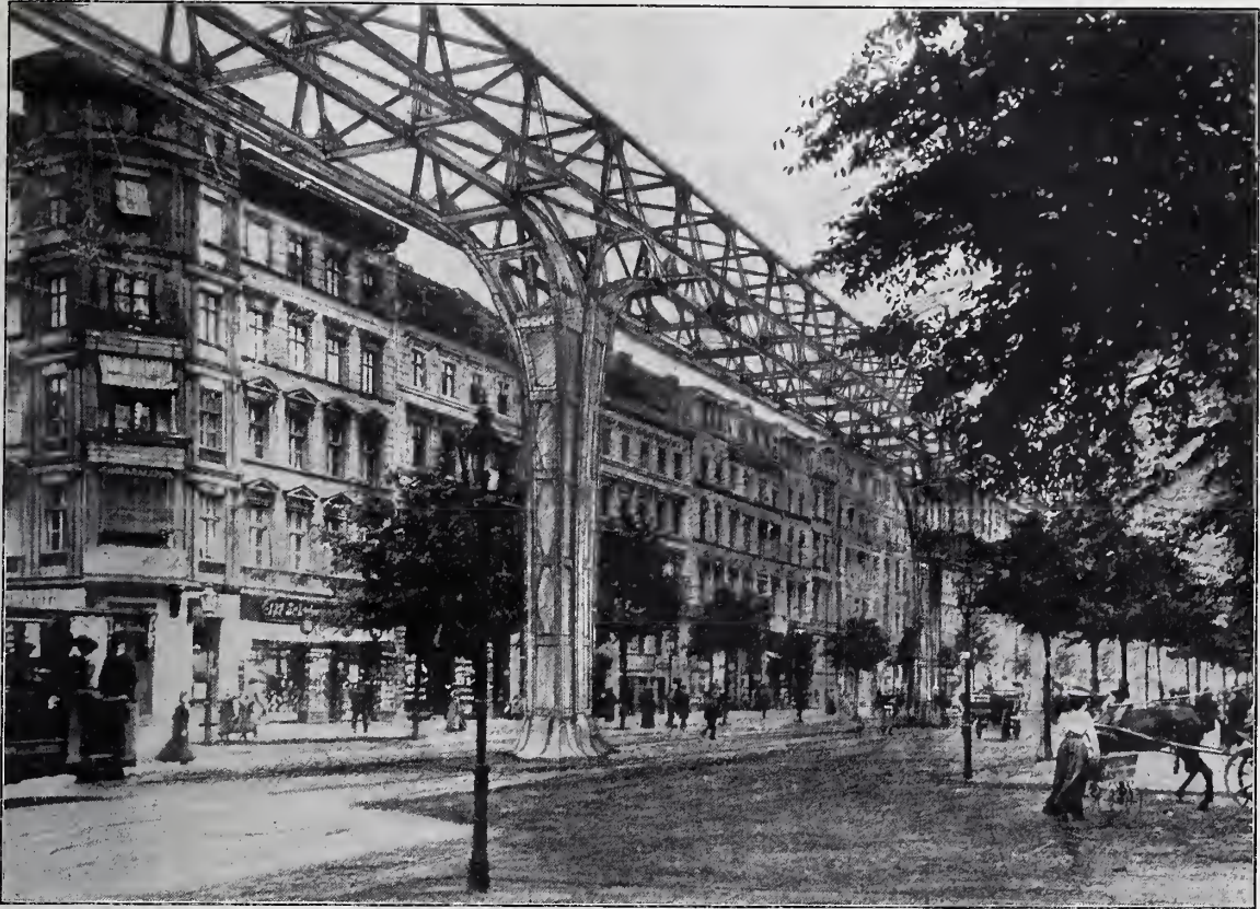
Abbildg. 2. Vierwandiger Fachwerkträger für rd. 30 m Stützweite mit Mittelstütze. Stadtbaustr. Jautschus, Berlin.
