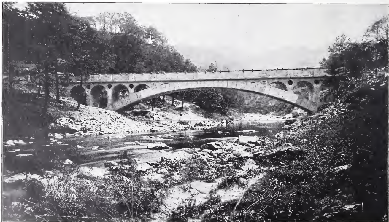
Kanalbrücke über die Murg bei Weisenbach. Spw. 40 m, Pfeil 5 m. Erbaut 1885. (Erste weitgespannte Betonbrücke in Deutschland.) Fortschritte im Bau weit gespannter massiver Brücken.
