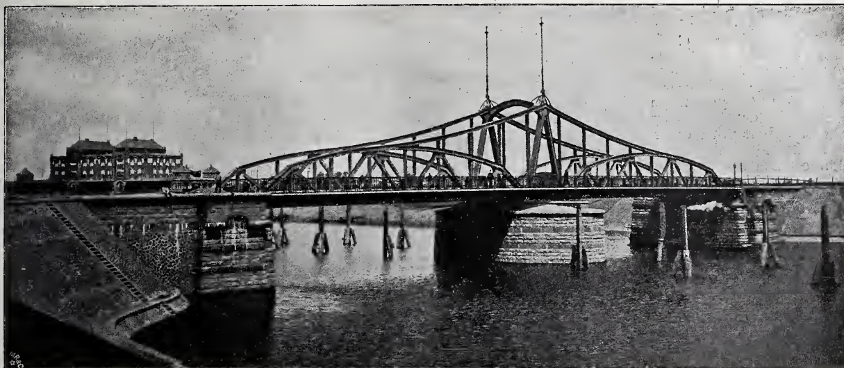
Abbildg. 2. Drehbrücke über der Hafeneinfahrt.
