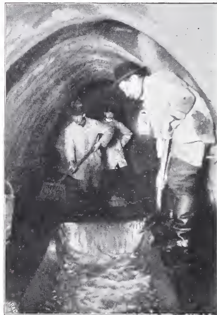
Abbildg. 26. Abbildg. 25 im Betrieb.
