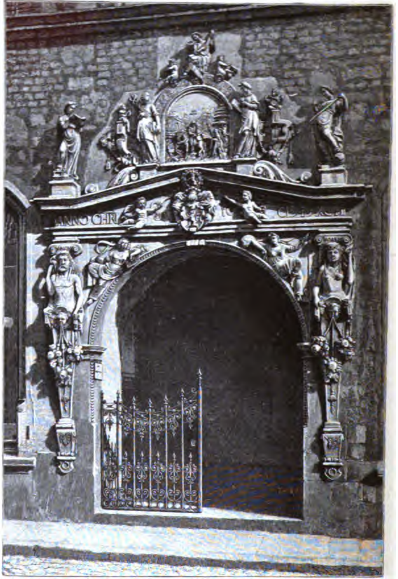
Abb. 556. Portal des ehemaligen Martinsgymnasiums zu Braunschweig (1592).
