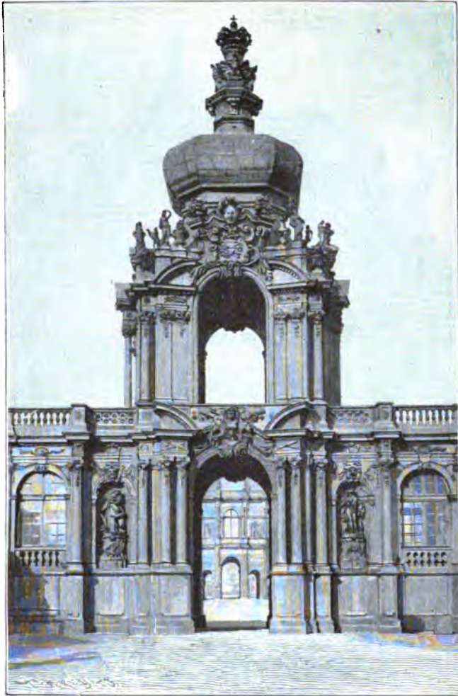
Abb. 648. Südlicher Eingang am Zwinger zu Dresden.
