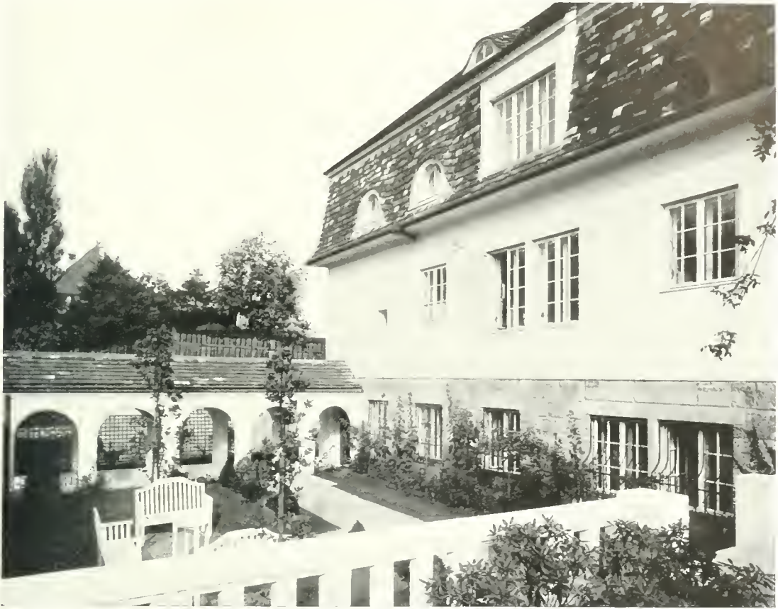
ARCHITEKT FRITZ ZEYMER WIEN.
