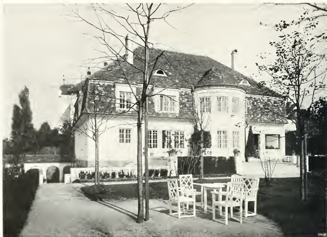
ARCHITEKT FRITZ ZEYMER WIEN.
