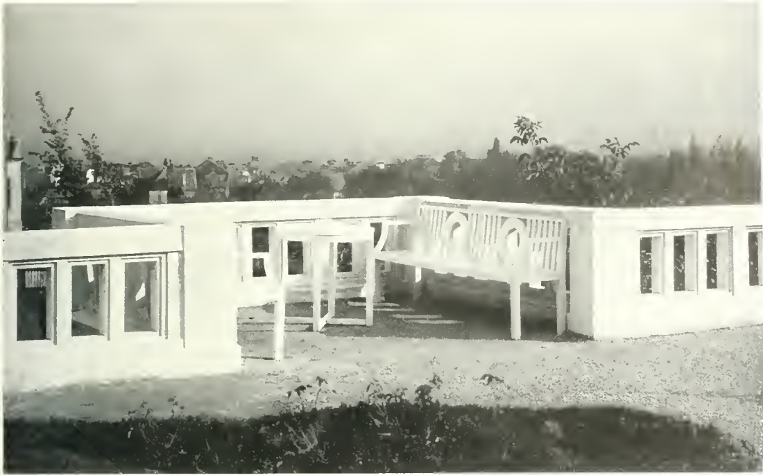
ARCHITEKT FRITZ ZEYMER - WIEN.
