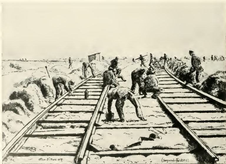
ERICH BÜTTNER BERLIN. RADIERUNG »BAHNBAU AUF DEM TEMPELHOFFER FELD« 1914.
