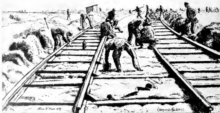
ERICH BÜTTNER BERLIN, RADIERUNG BAHNBAU AUF DEM TEMPELHOFFER FELD 1914.
