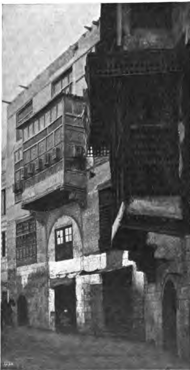
Häuser mit Balkonen und Muschrabijen in Kairo. (Zu S. 95.) (Nach einer photographischen Aufnahme.)
