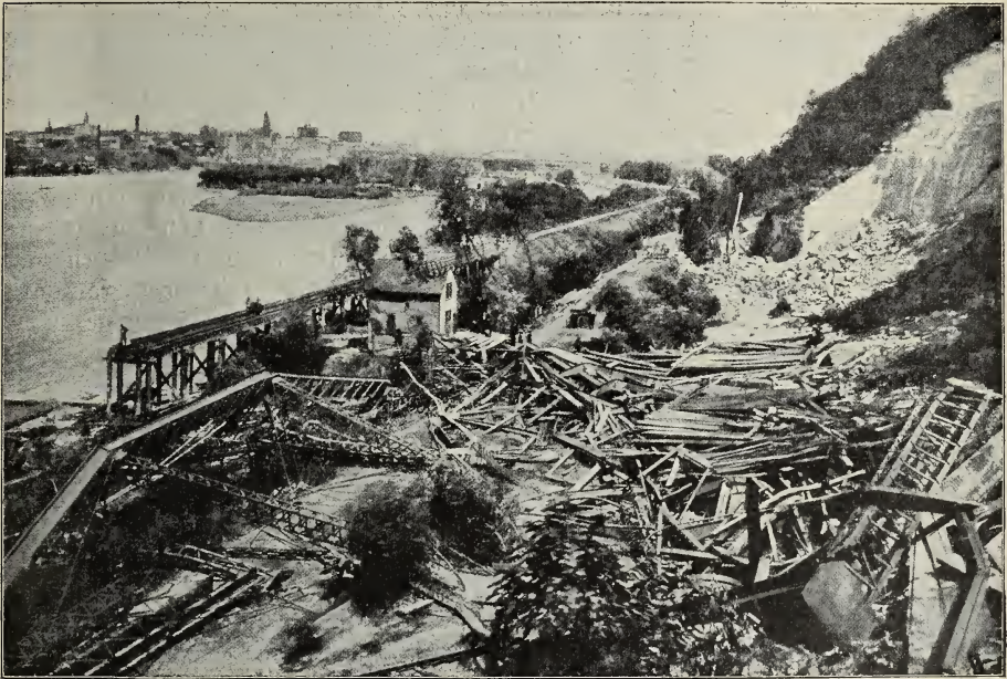
St. Paul: Die durch den Cyklon vom 20. August 1904 zerstörte Hochbrücke (Zu S. 103.)
