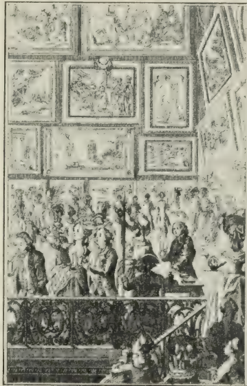
Escalier conduisant au Salon.
