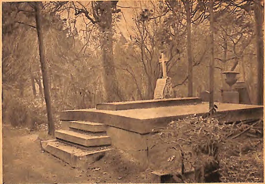
Gruftanlage mit Treppenanordnung. St. Katharinen.
