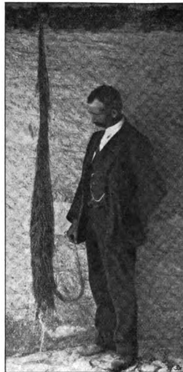
Teil eines Wurzelzopfes aus einem Entwässerungsröhr.
